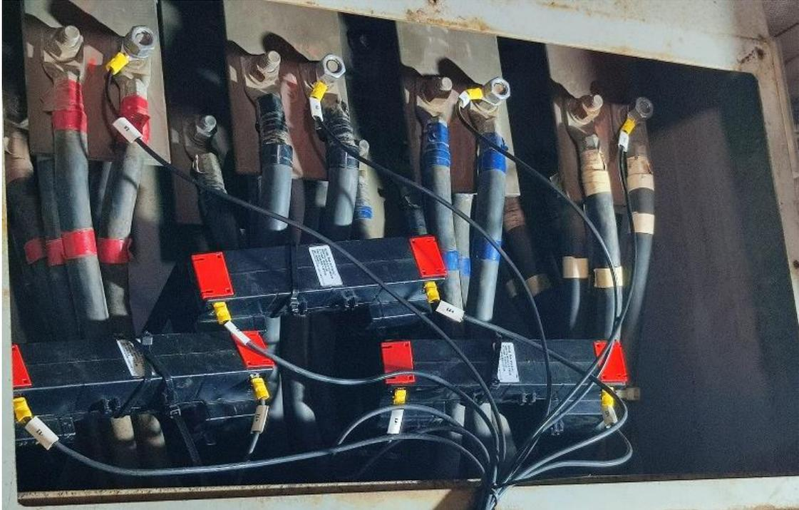
*Figura 9.35 – Conexión TTCC externos y tensión directa sobre la barra de 400 V*
