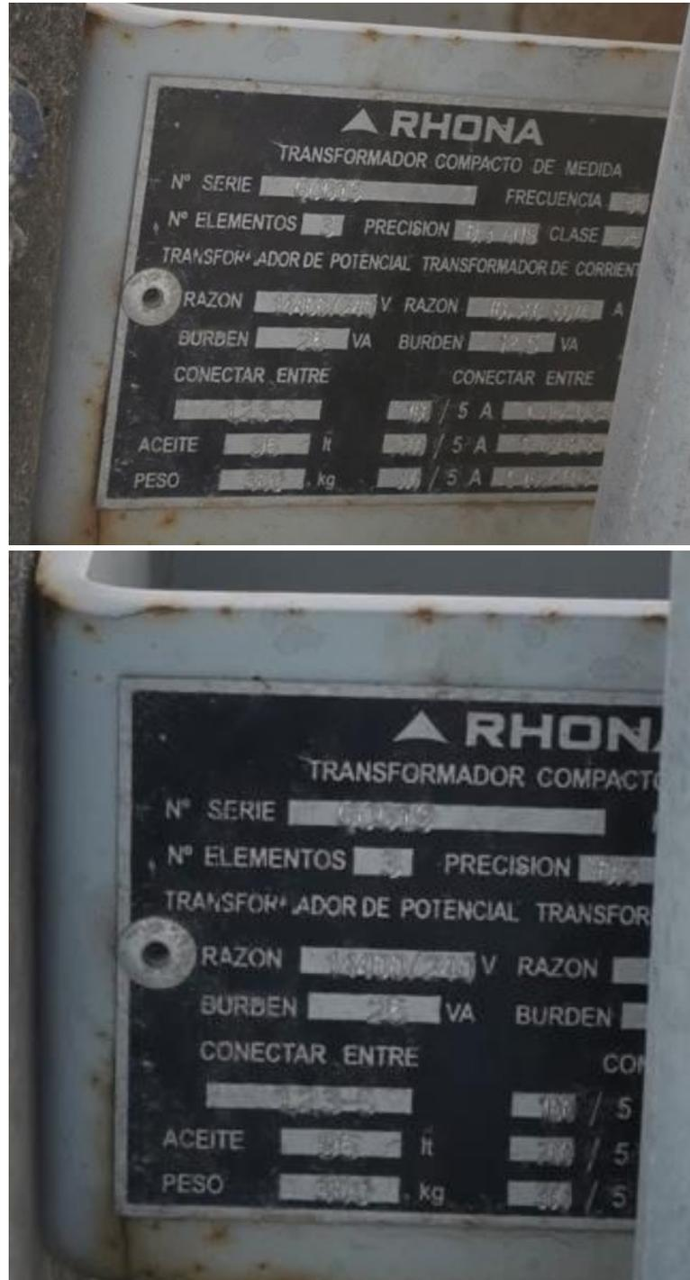
Figura 9.14 – Datos de placa del equipo compacto de medida para la medición de potencia neta
