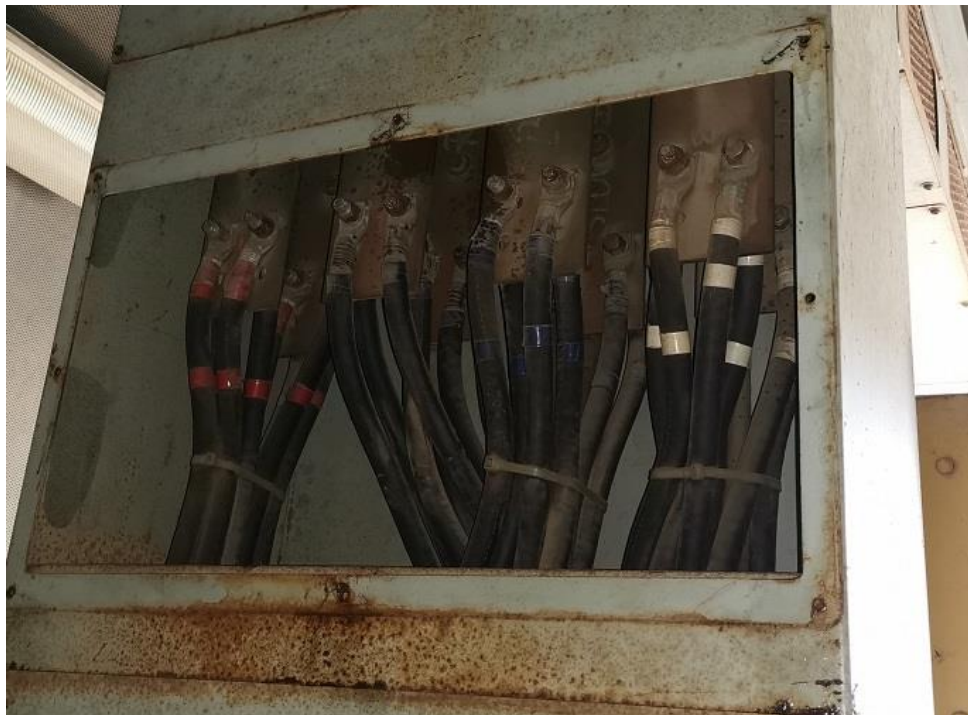
Figura 9-9 – Puntos de instalación TTCC externo
