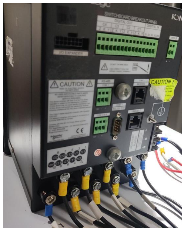
Figura 9-46 – Medidor de potencia bruta/FP unidad G16
