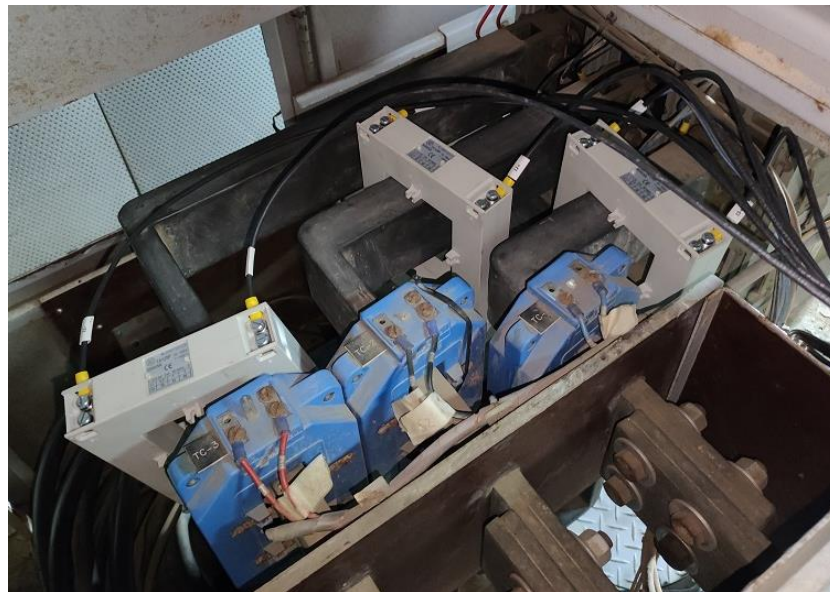
Figura 9-49 – Conexión TTCC externos (Unidad G18)
