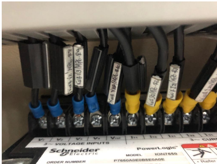
Figura 9-10 – Bornes medidor de potencia bruta – Unidad 1
