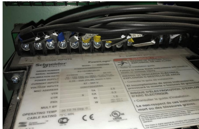
MEDIDOR ENERGIA NETA UNIDAD 3
