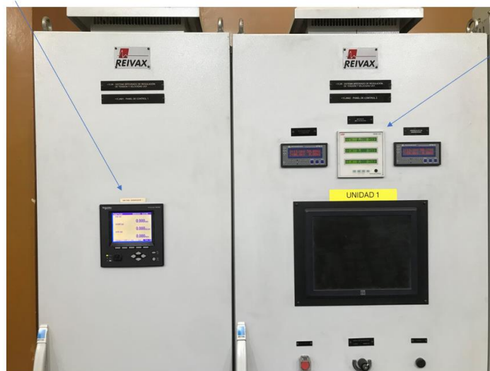
Figura 9.10 – Ubicación medidor de Potencia Bruta
