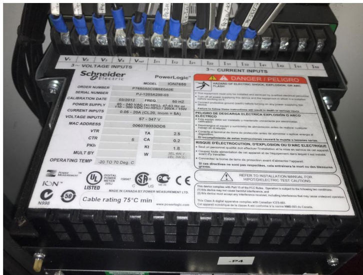
MEDIDOR ENERGIA BRUTA UNIDAD 3
