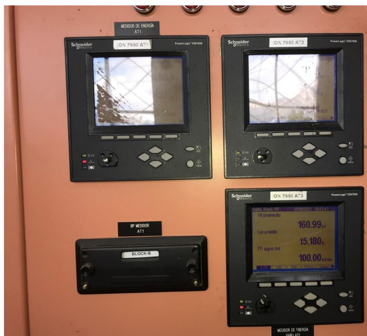
Figura 9.13 – Medidor de Potencia Neta
