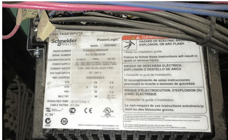
MEDIDOR ENERGIA NETA UNIDAD 3
