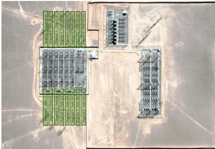
Figura 1-1. Imagen satelital de S/E Kimal y paños en 220 kV.
