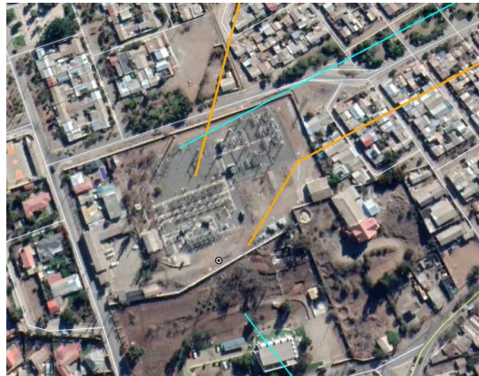
Ilustración 23. Vista aérea S/E Ovalle.
