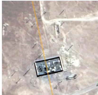
Ilustración 8. Vista aérea S/E Tap off Dolores
