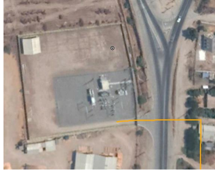
Ilustración 2. Vista aérea S/E Bollenar.
