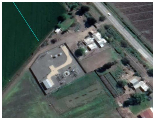
Ilustración 18. Vista aérea S/E Lihueimo.
