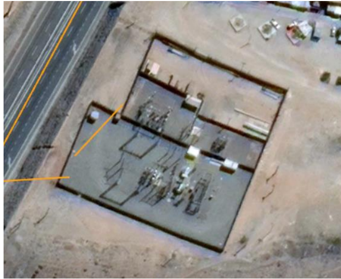
Ilustración 36 Vista aérea S/E Vallenar.
