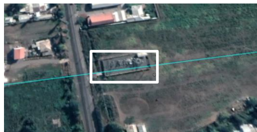
Ilustración 21. Vista aérea S/E Nancagua.
