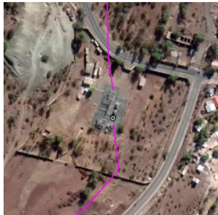
Ilustración 7. Vista aérea S/E Combarbalá.
