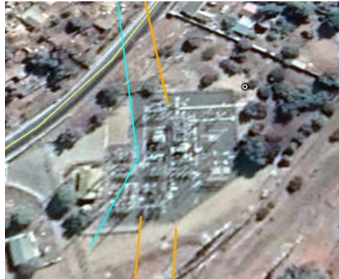
Ilustración 13. Vista aérea S/E Illapel.
