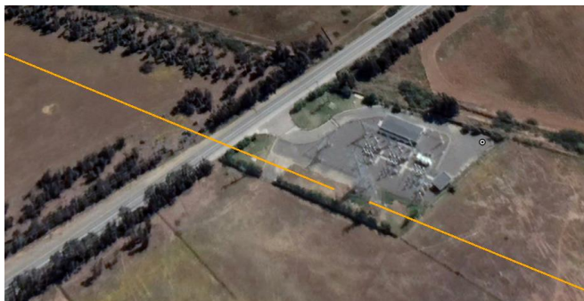
Ilustración 17. Vista aérea S/E Leyda.
