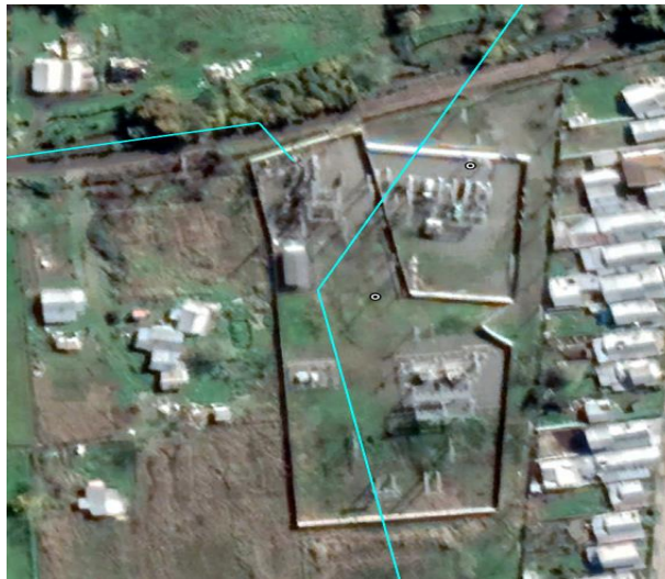
Ilustración 41. Vista aérea S/E Cocharcas.
