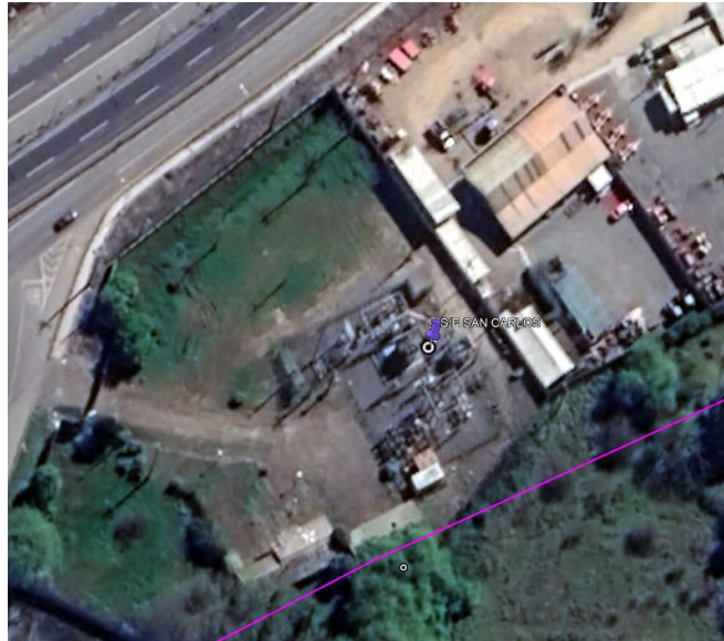
Ilustración 32. Vista aérea S/E San Carlos.
