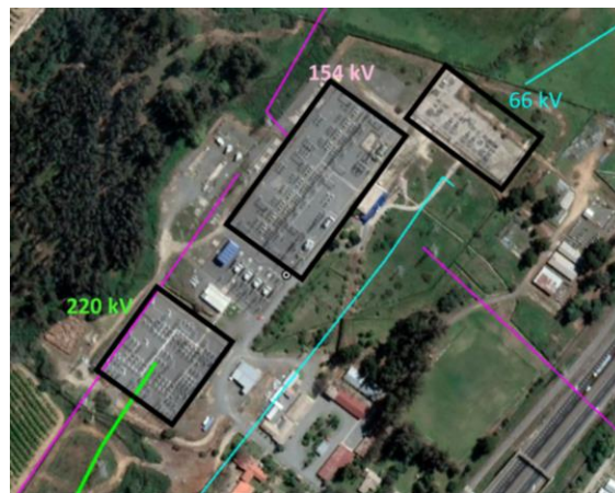
Ilustración 14. Vista aérea S/E Itahue.
