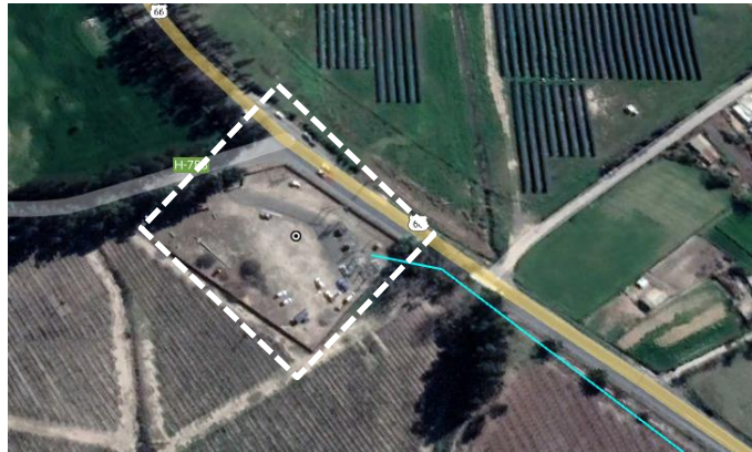
Ilustración 10. Vista aérea S/E El Manzano CGE
