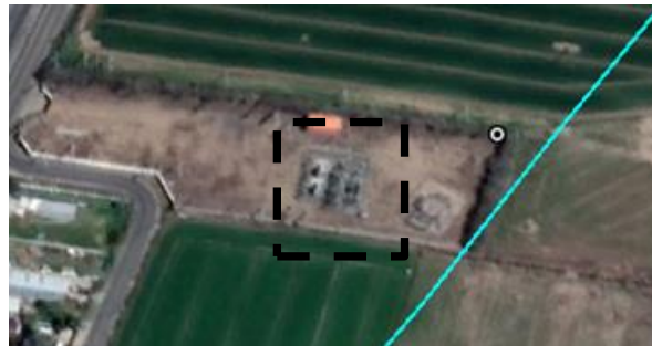
Ilustración 6. Vista aérea S/E Chimbarongo
