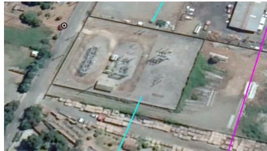
Ilustración 5. Vista aérea S/E Chacahuín.
