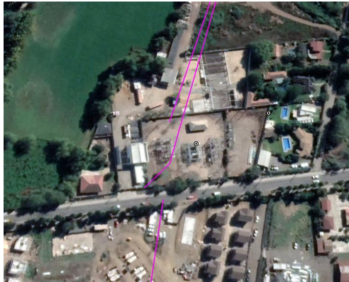
Ilustración 33. Vista aérea S/E San Vicente de Tagua Tagua
