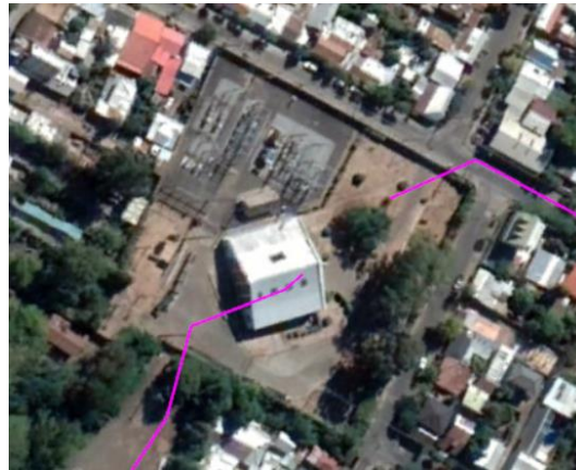
Ilustración 34. Vista aérea S/E Santa Elvira.
