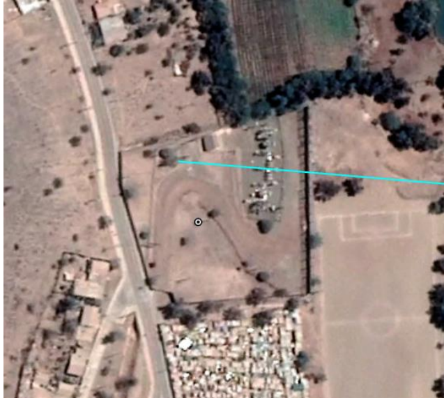
Ilustración 20. Vista aérea S/E Monte Patria.
