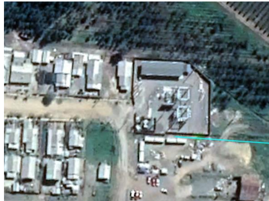
Ilustración 1. Vista aérea S/E Alcones.
