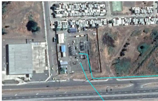
Ilustración 43. Vista aérea S/E Cabrero.
