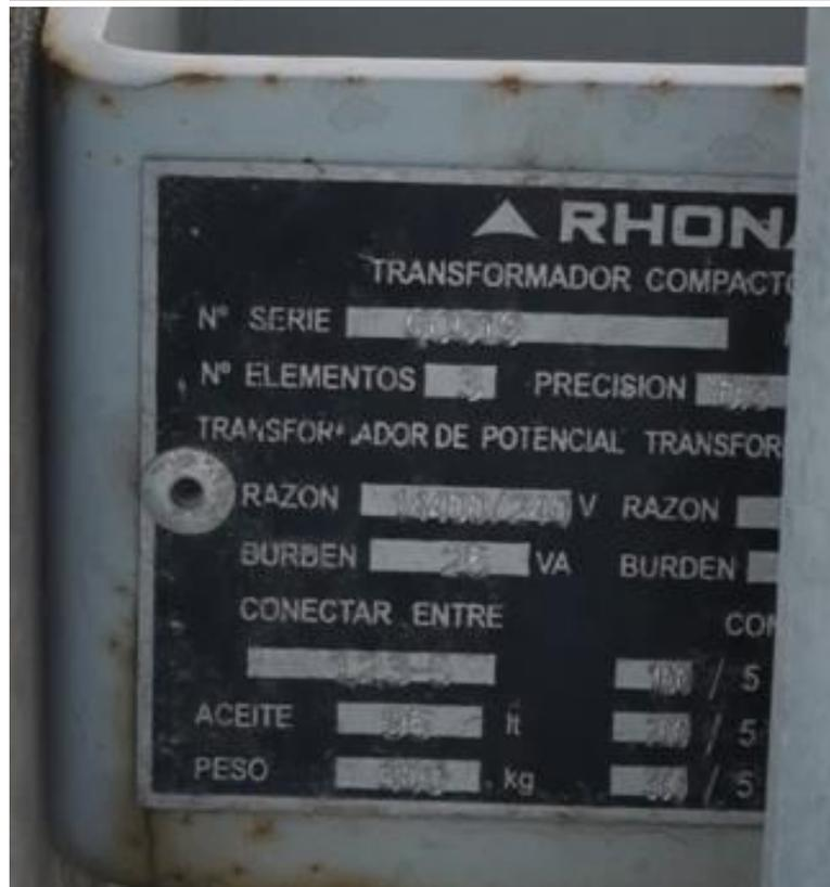
Figura 9.14 – Datos de placa del equipo compacto de medida para la medición de potencia neta
