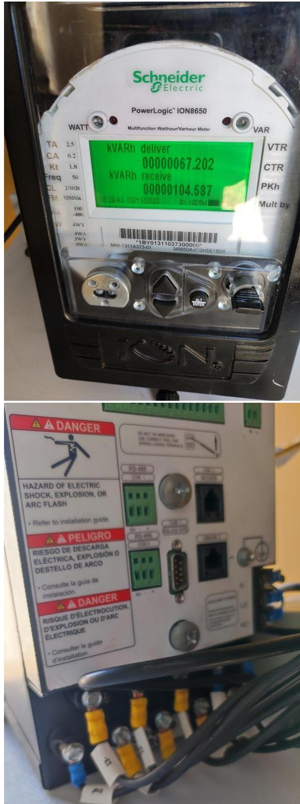
Figura 9.32 – Medidor de potencia bruta/FP unidad G9
