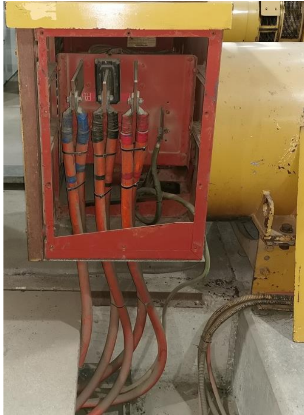
Figura 9.16 – Puntos de instalación TTCC externo
