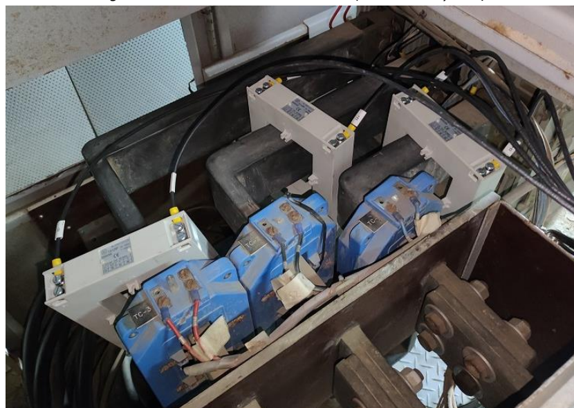
Figura 9.48 – Conexión TTCC externos (Unidad G18)
