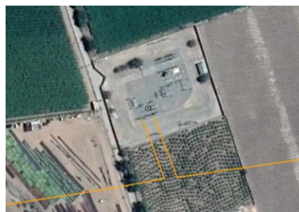
Ilustración 33. Vista aérea S/E Vicuña.
