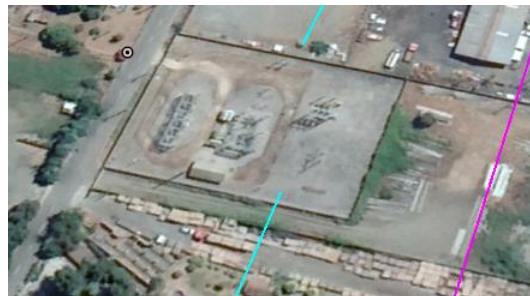
Ilustración 2. Vista aérea S/E Chacahuín.
