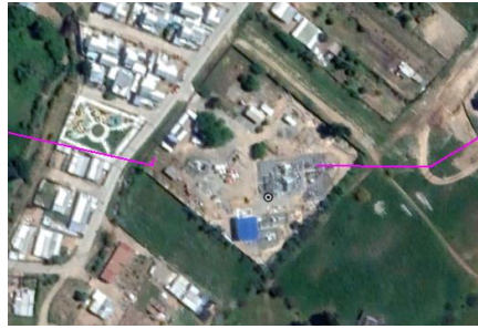
Ilustración 25. Vista aérea S/E Cauquenes.
