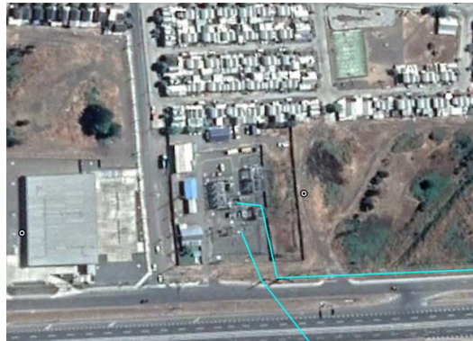
Figura 4-13. Vista aérea S/E Cabrero.
