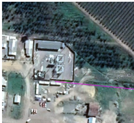
Ilustración 23. Vista aérea S/E Alcones.
