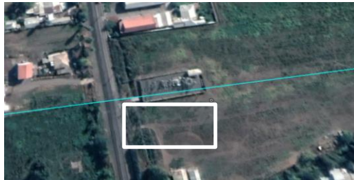
Ilustración 14. Vista aérea S/E Nancagua.
