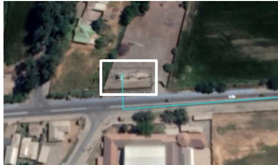
Ilustración 11. Vista aérea S/E Loreto.
