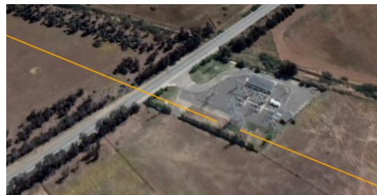
Ilustración 9. Vista aérea S/E Leyda.
