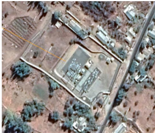
Ilustración 20. Vista aérea S/E Salamanca
