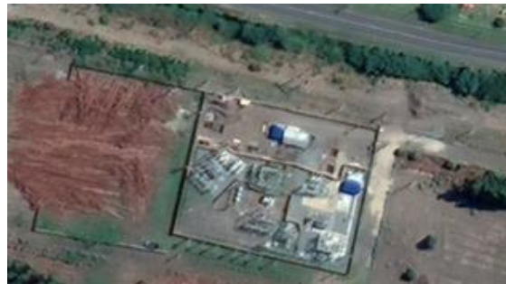
Ilustración 34. Vista aérea S/E Negrete.
