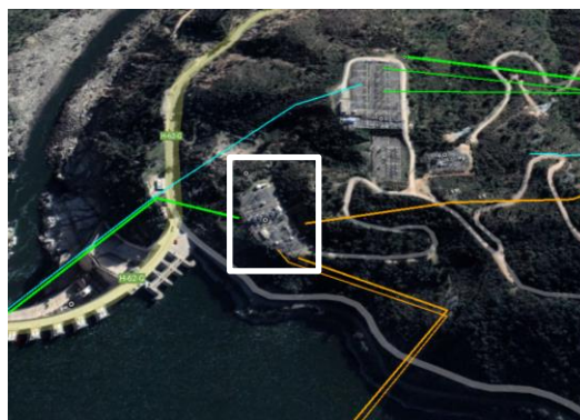
Ilustración 18. Vista aérea S/E Quelentaro.
