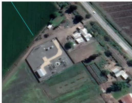
Ilustración 10. Vista aérea S/E Lihueimo.
