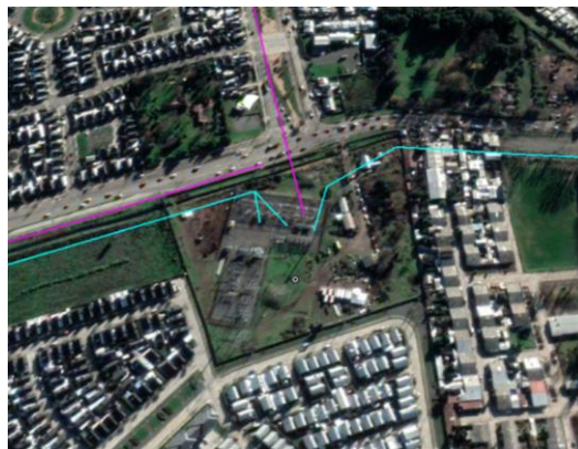
Ilustración 12. Vista aérea S/E Los Ángeles.
