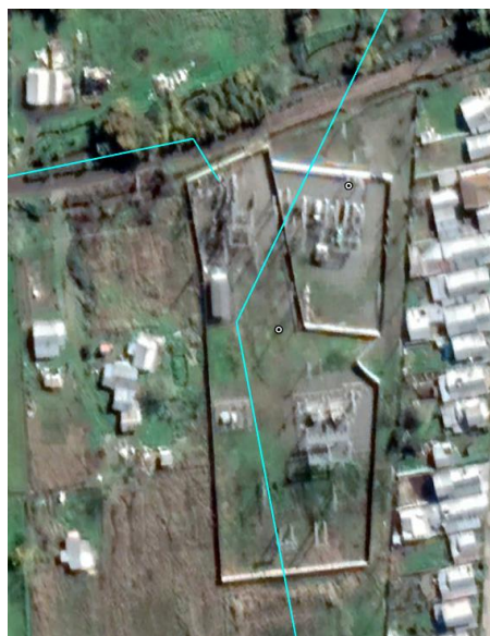
Figura 6.5 Vista aérea S/E San Cocharcas.
