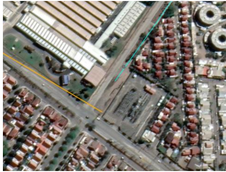
Figura 5.9 Vista aérea S/E San Rafael Chilquinta.
