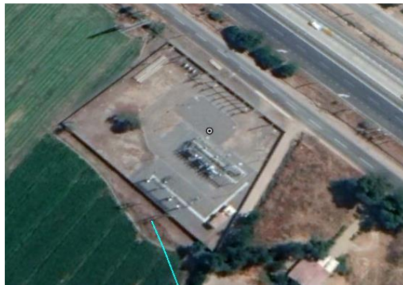
Ilustración 4. Vista aérea S/E Curacaví.
