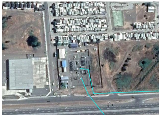
Figura 4-7. Vista aérea S/E Cabrero.
