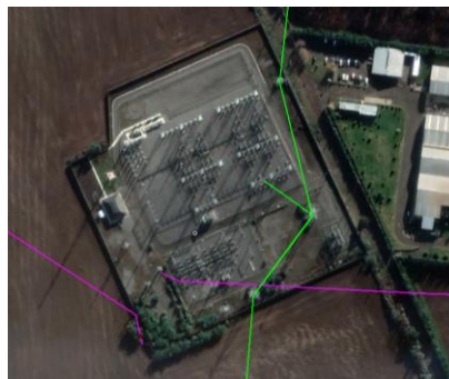
Ilustración 27. Vista aérea S/E Duqueco.
