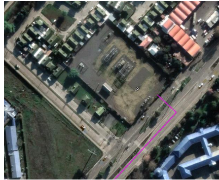
Ilustración 28. Vista aérea S/E El Avellano.
