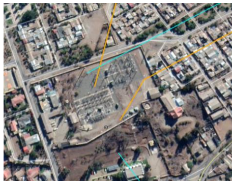
Ilustración 16. Vista aérea S/E Ovalle.
