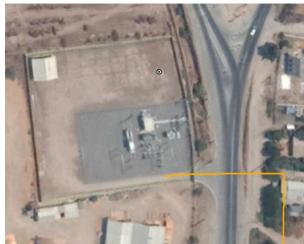
Ilustración 1. Vista aérea S/E Bollenar.
