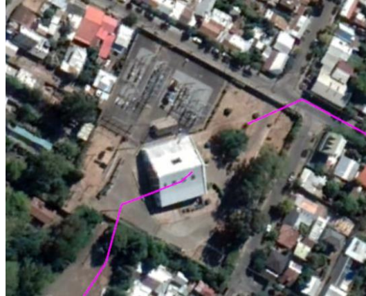
Ilustración 21. Vista aérea S/E Santa Elvira.
