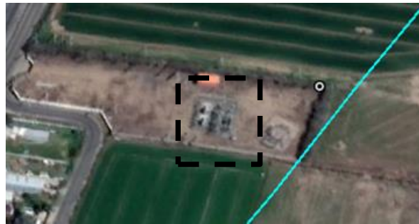
Ilustración 3. Vista aérea S/E Chimbarongo
