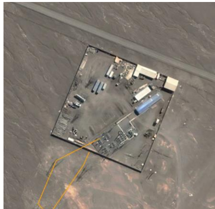
Ilustración 32. Vista aérea S/E Uribe.
