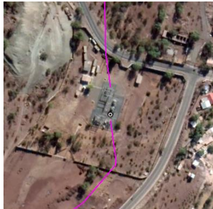
Ilustración 26. Vista aérea S/E Combarbalá.
