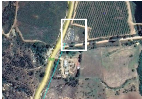
Ilustración 19. Vista aérea S/E Ranguilí.
