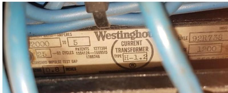
Figura 9-6 – Foto de placa transformador de corriente
