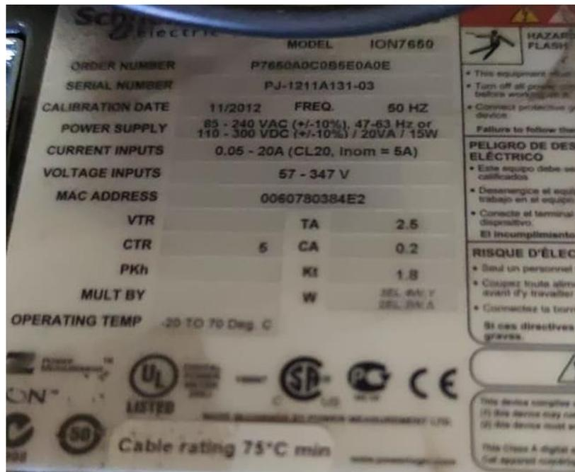
Figura 9-9 – Datos de placa medidor de potencia bruta y factor de potencia - Unidad U3
