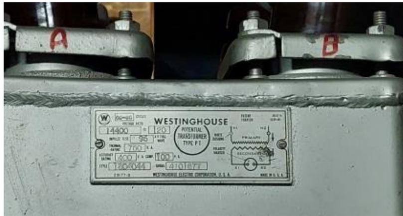
Figura 9-5 – Foto de placa transformador de tensión
