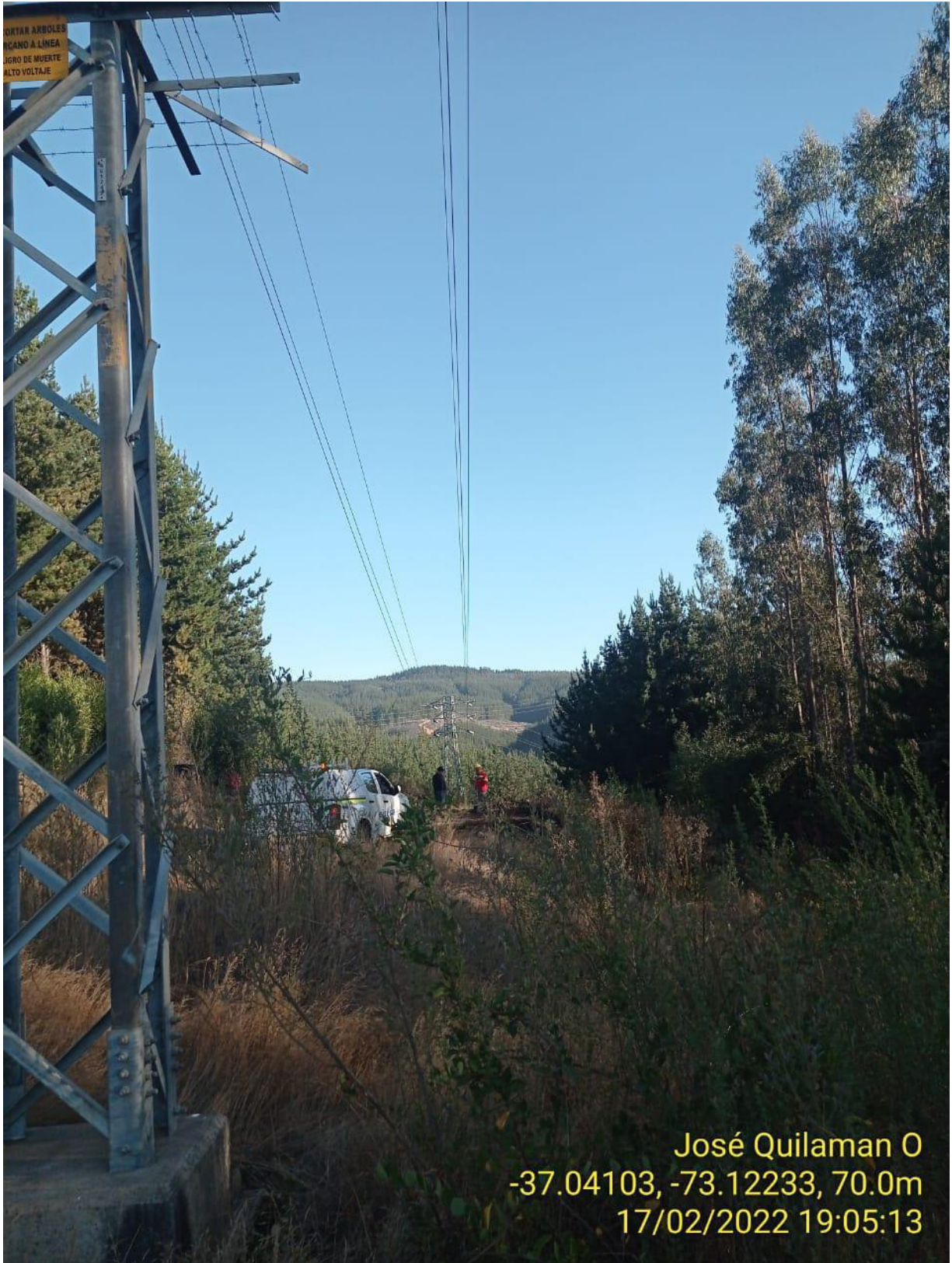
Fotografía N° 1: Resto del árbol fuera de franja talado por terceros entre las estructuras 25 y 26 de la línea LT El Manco-Andalacán N°2.
