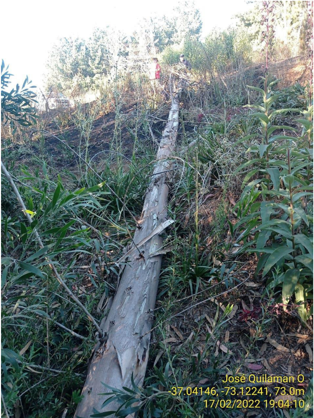
Fotografía N° 2: Resto del árbol fuera de faranja talado por terceros entre las estructuras 33 y 34 de la línea LT El Manco-Andalicán N°2.
