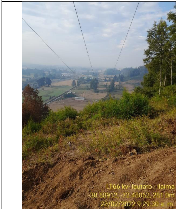
Vista después vano 194 - 195
