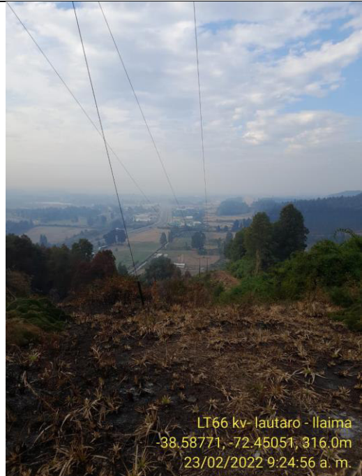
Vista después vano 193 - 194
