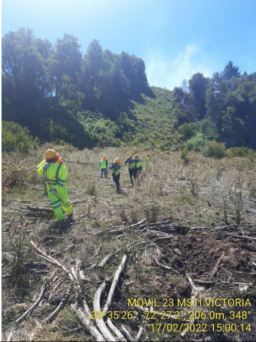
Tendido de conductor forma manual
