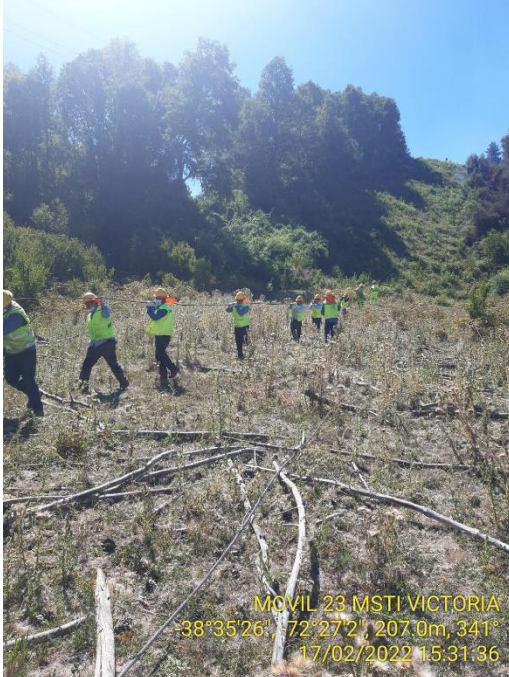
Tendido de conductor forma manual
