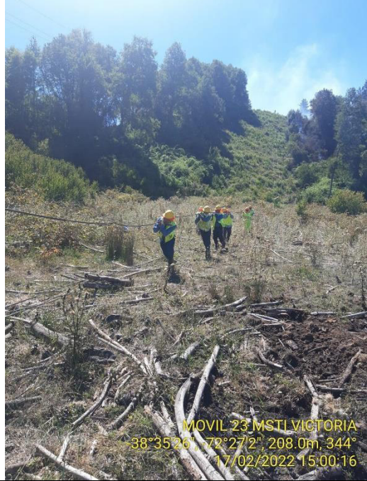
Tendido de conductor forma manual
