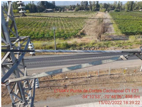
Figura 3.- En la fotografía se muestra preformada instalada en fase superior de la estructuras N°21 circuito 1
