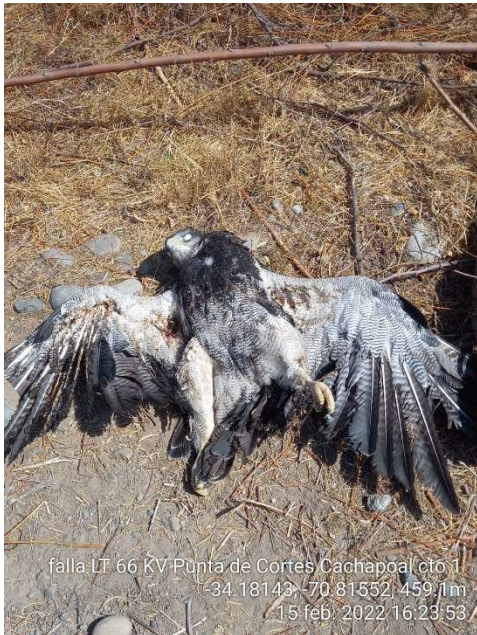
Figura 1.- En la fotografía se muestra el ave causante de descarga en estructura N°21
