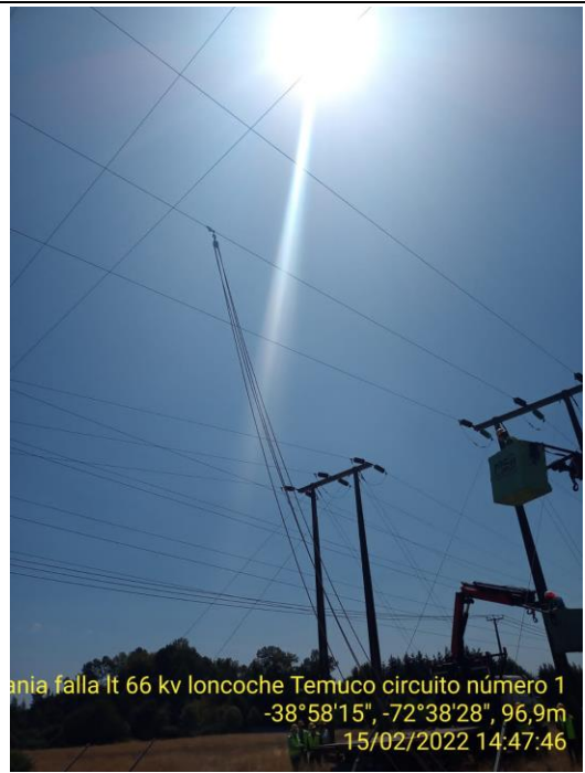
Vista terminando las operaciones
