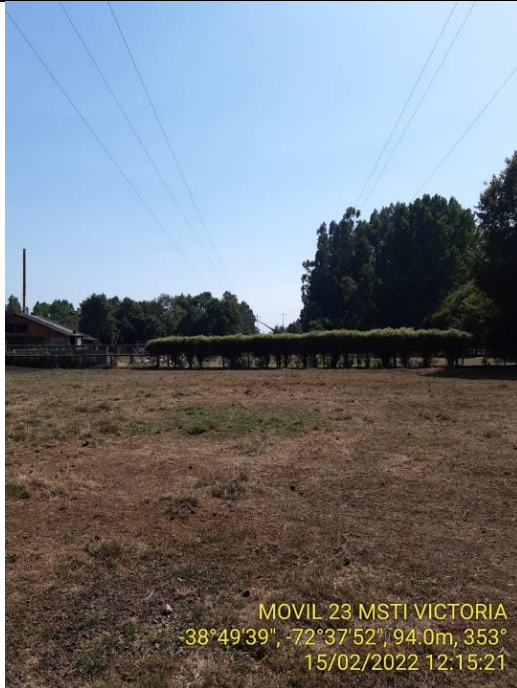
Después Vano E309 - E310
