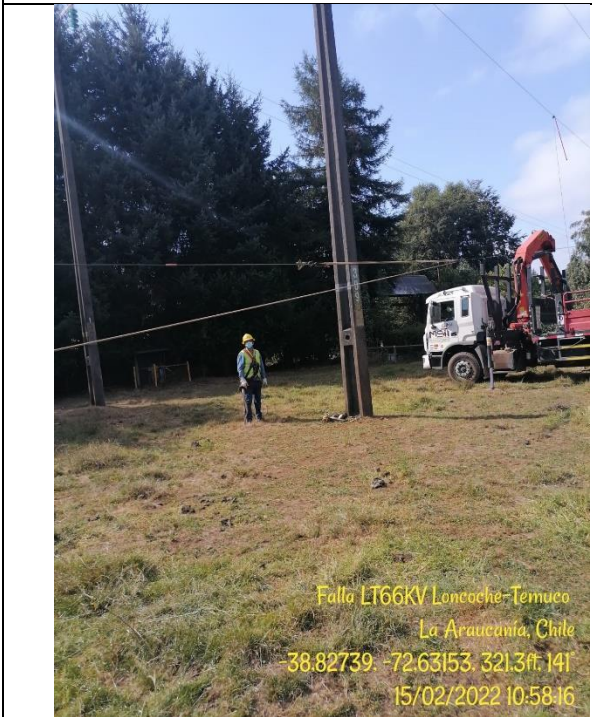
Reparación de LT
