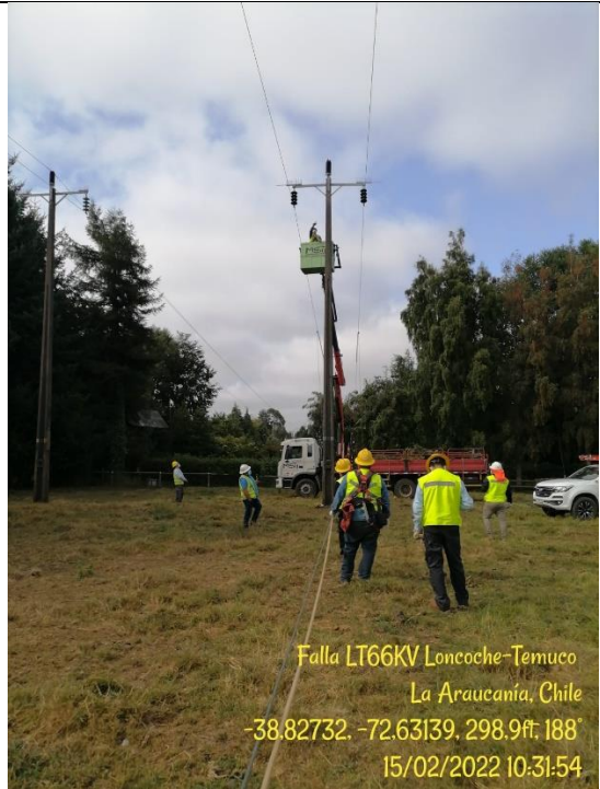
Reparación de LT
