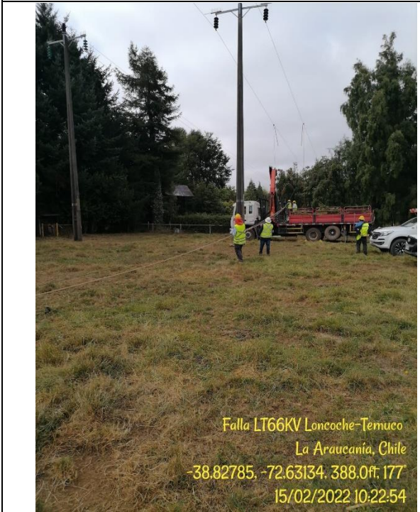
Reparación de LT
