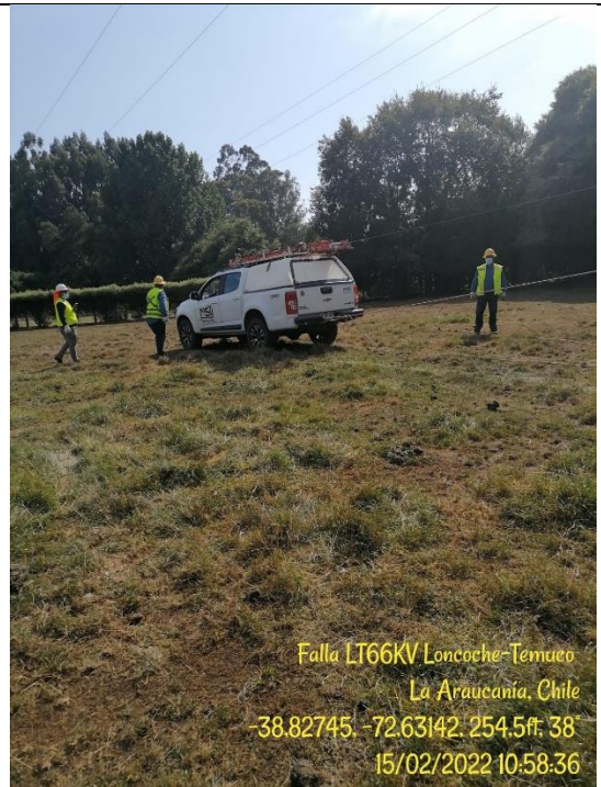
Reparación de LT
