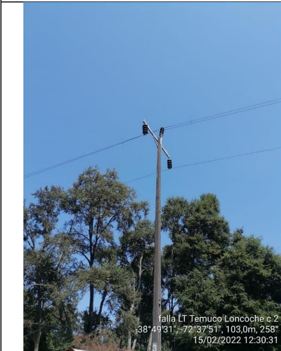
Operaciones en E310 Reparada
