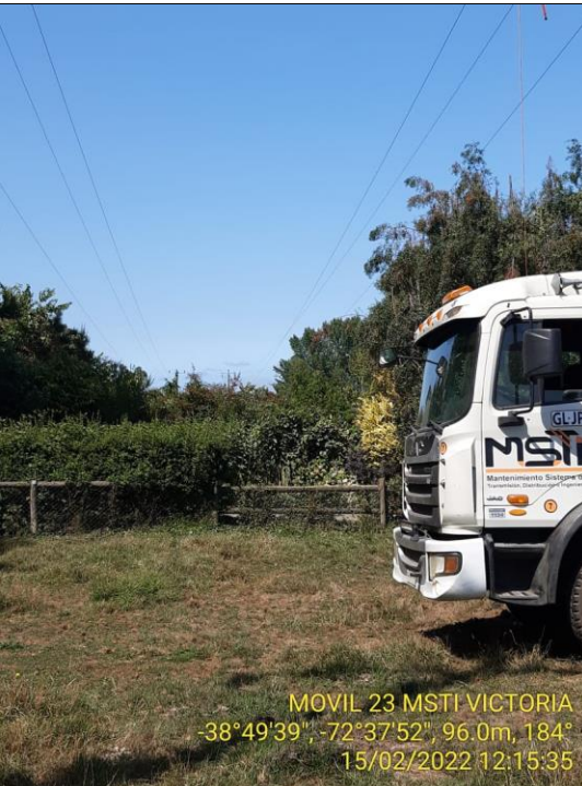
Después Vano E309 - E310
