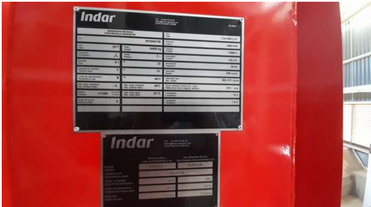
Figura 8: Placa de identificación Unidad Generador 2
