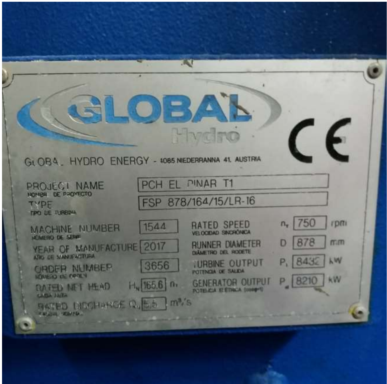
Figura 5: Placa de identificación Unidad Turbina 1 Modelo Francis.
