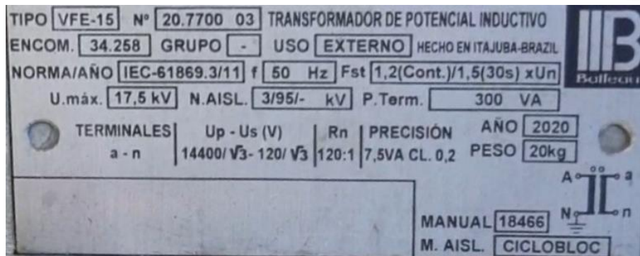
Figura 9.6 – Foto de placa transformador de tensión
