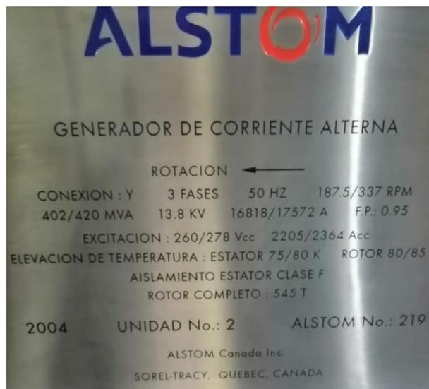
Figura 4.5 – Datos de placa del generador U2
