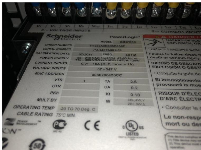
Figura 9.8 – Datos de placa medidor de potencia neta – Circuito 2
