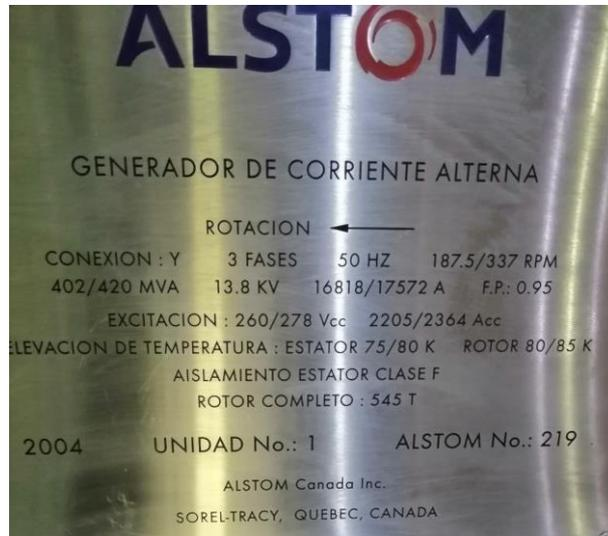
Figura 4.4 – Datos de placa del generador U1
