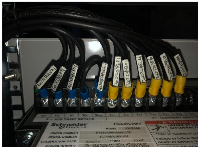
Figura 9.10 – Bornes medidor de potencia neta – Circuito 2
