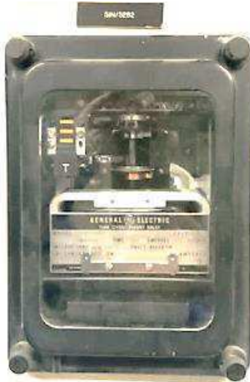
Figura 2: Señal de función de sobrecorriente 51N operada en relé GE IAC51
