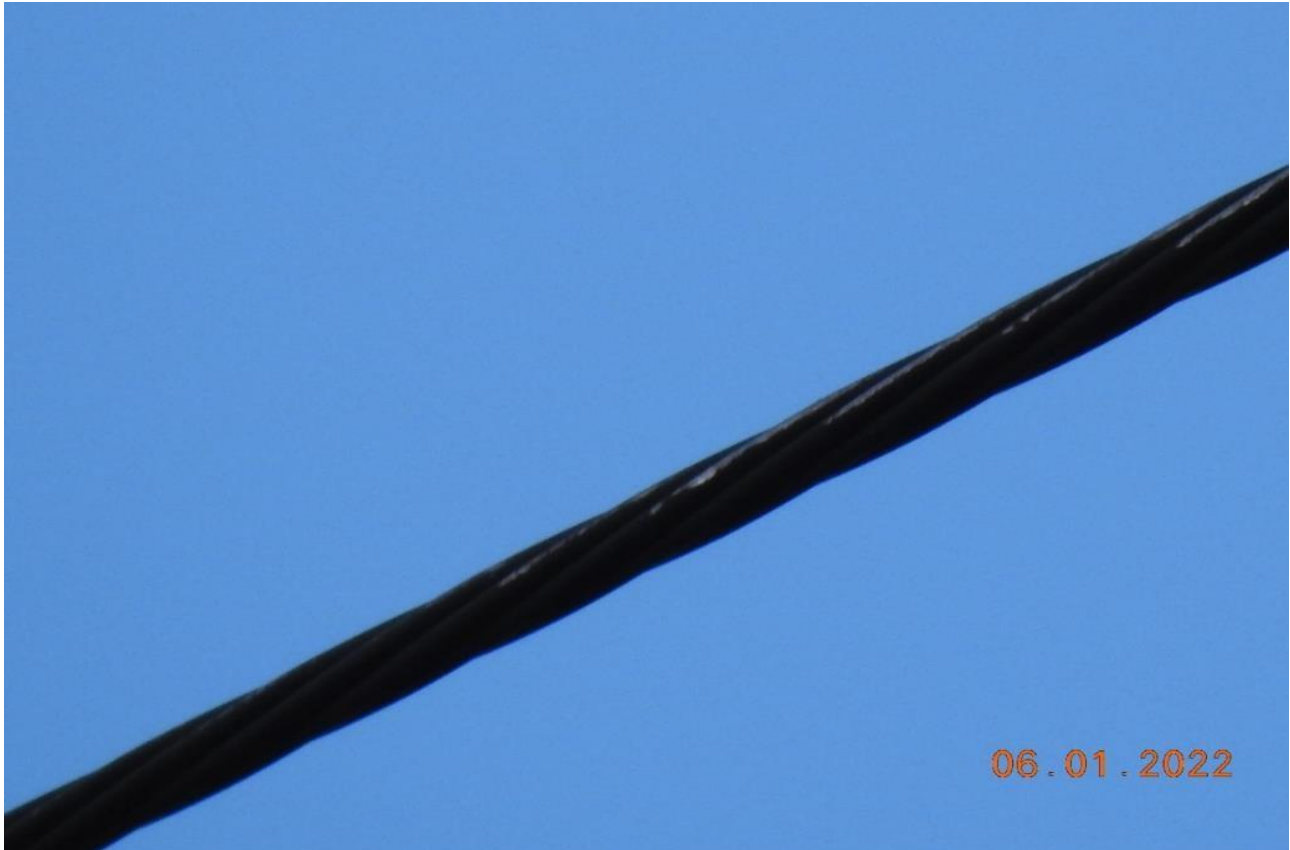
Fotografía 1: Muestra en conductor entre vanos estructura 162 – 163 con señal de arco eléctrico.
