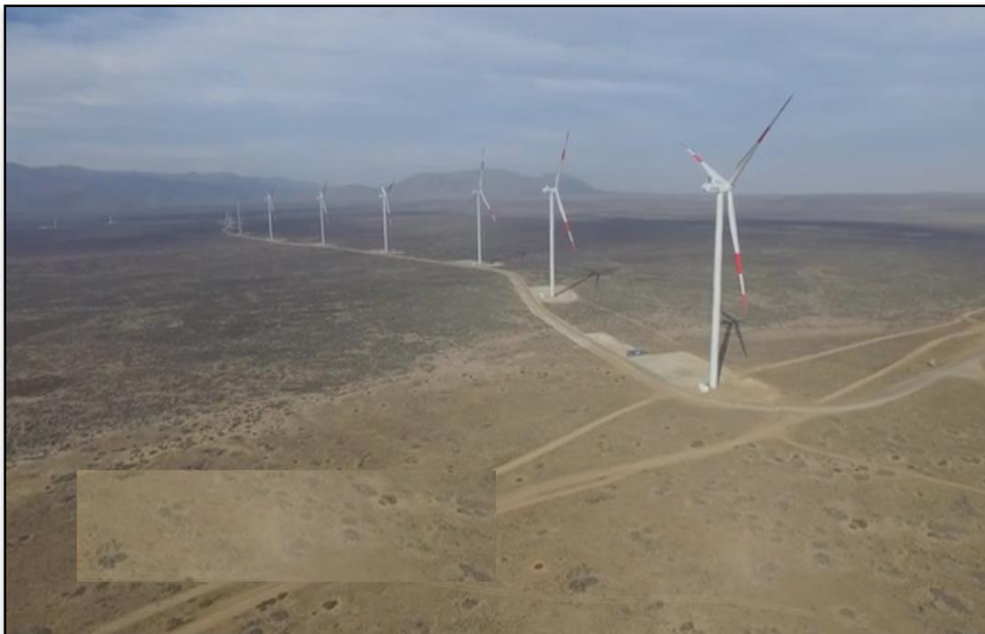
Figura 2.5.1. Vista general de la distribución del Parque Eólico San Juan.
