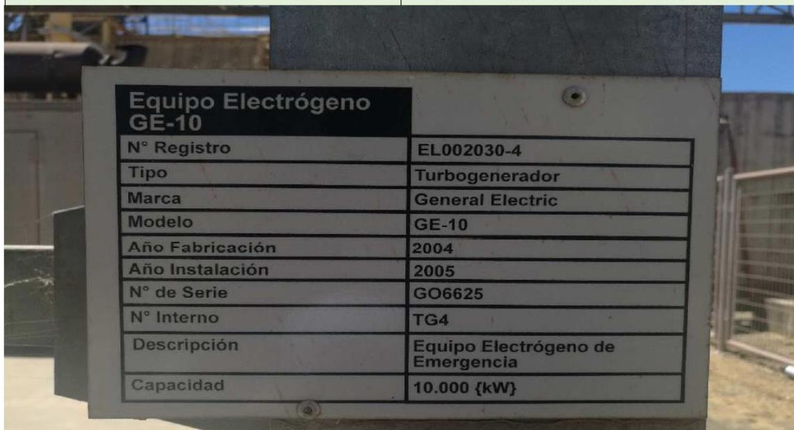
Figura 4.4 - Datos de placa de la turbina
