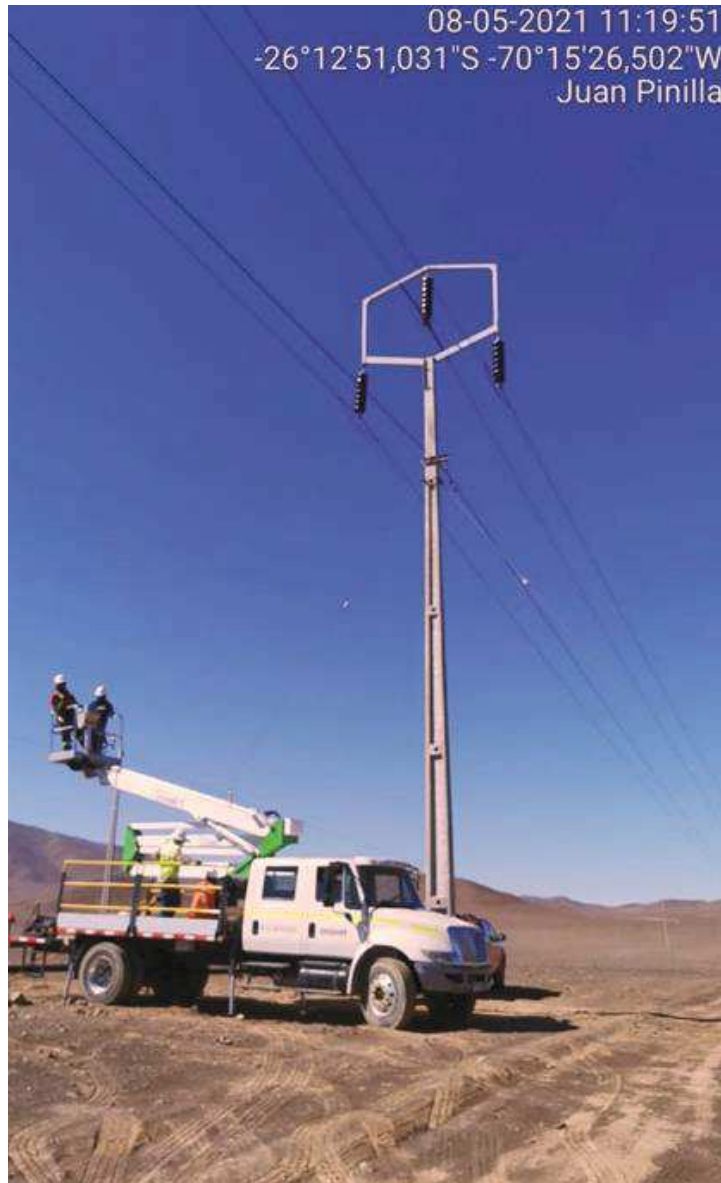
Figura N° 4 Estructura N°128 trabajos no ejecutados por falla camión Cesta
