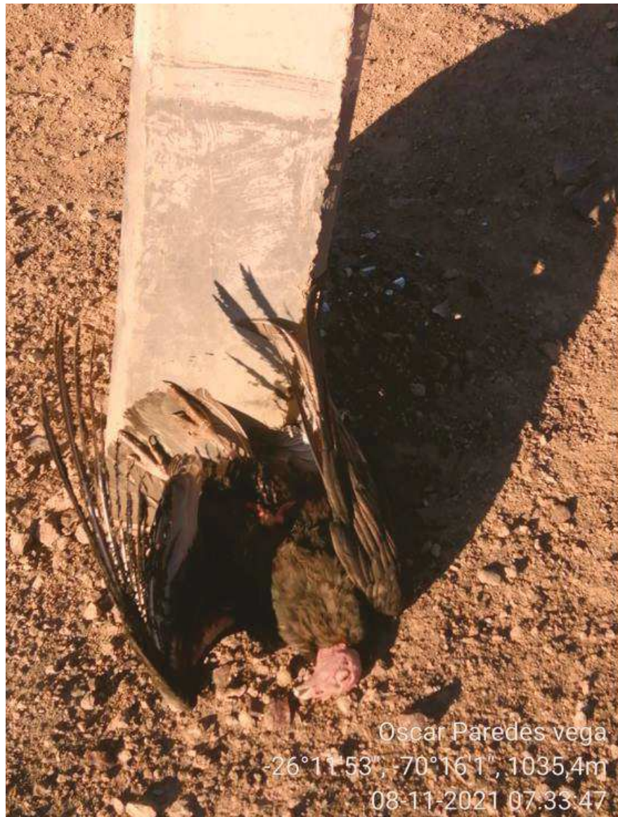
Fotografía N°2 detalle ave electrocutada encontrada al pie de Estructura N° 143 08/11/2021
