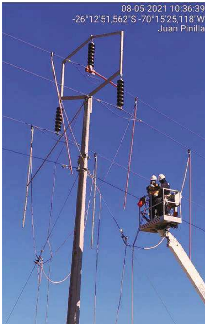
Figura N° 3 Detalle trabajos en estructura N° 135
