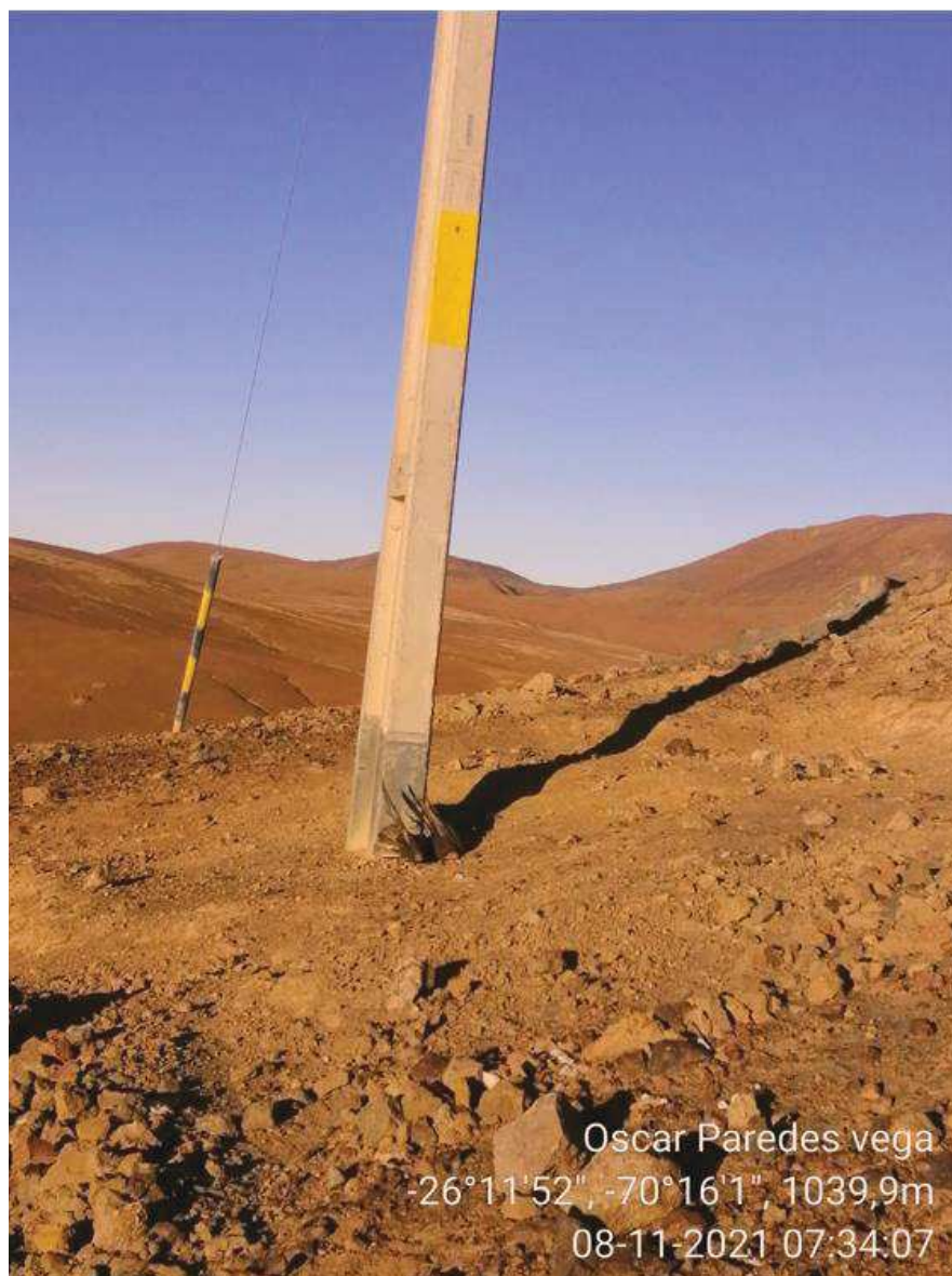
Fotografía N°1 ave electrocutada encontrada al pie de Estructura N° 143 08/11/2021
