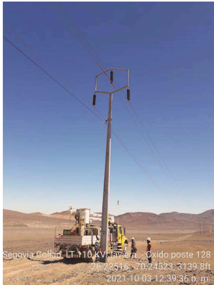
Figura N° 1 Zona de trabajos en estructura N° 128
