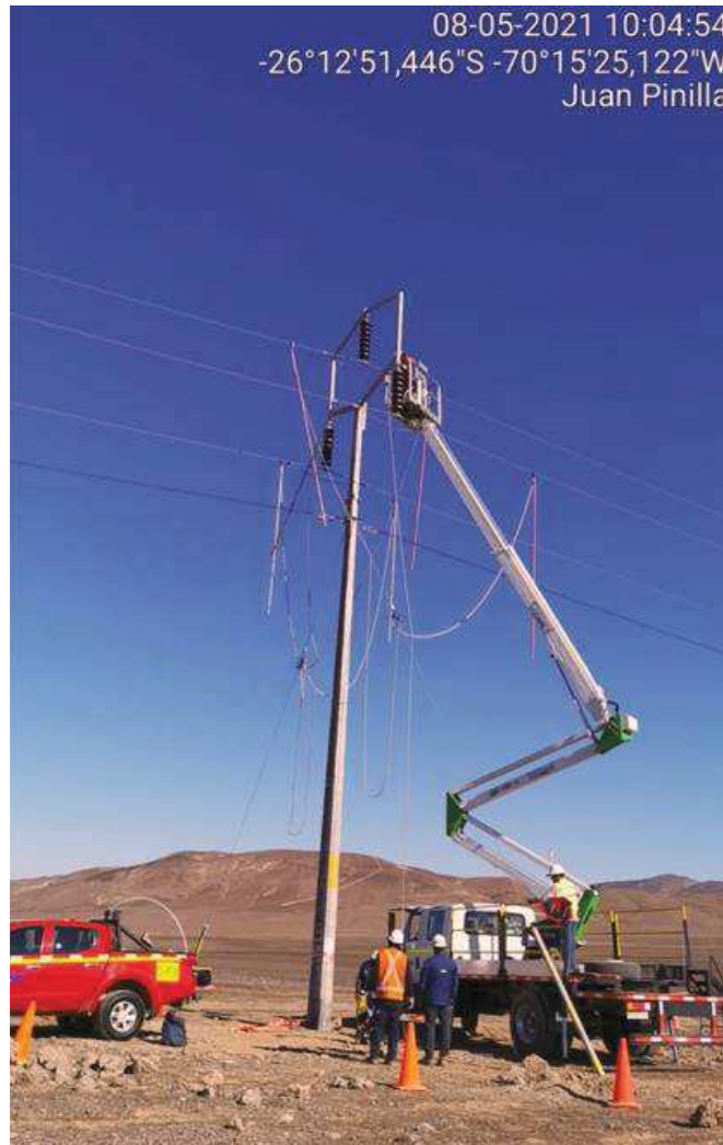
Figura N° 2 Zona de trabajos en estructura N° 135
