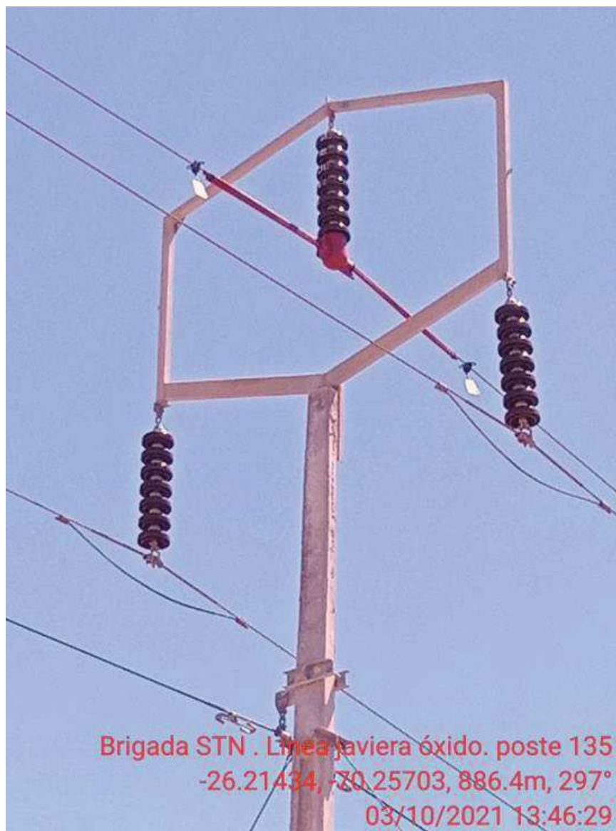
Figura N° 5 detalle trabajos ejecutados en estructura N° 135
