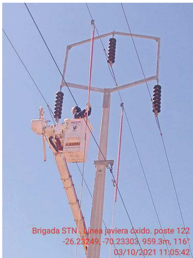
Figura N° 1 Zona de trabajos en estructura N° 122
