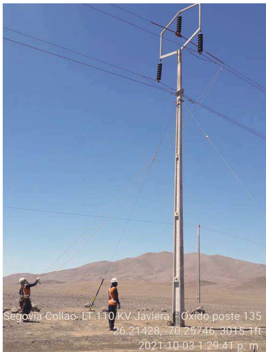
Figura N° 2 Mejoramiento instalación fundas protectoras aisladas en estructura N° 135
