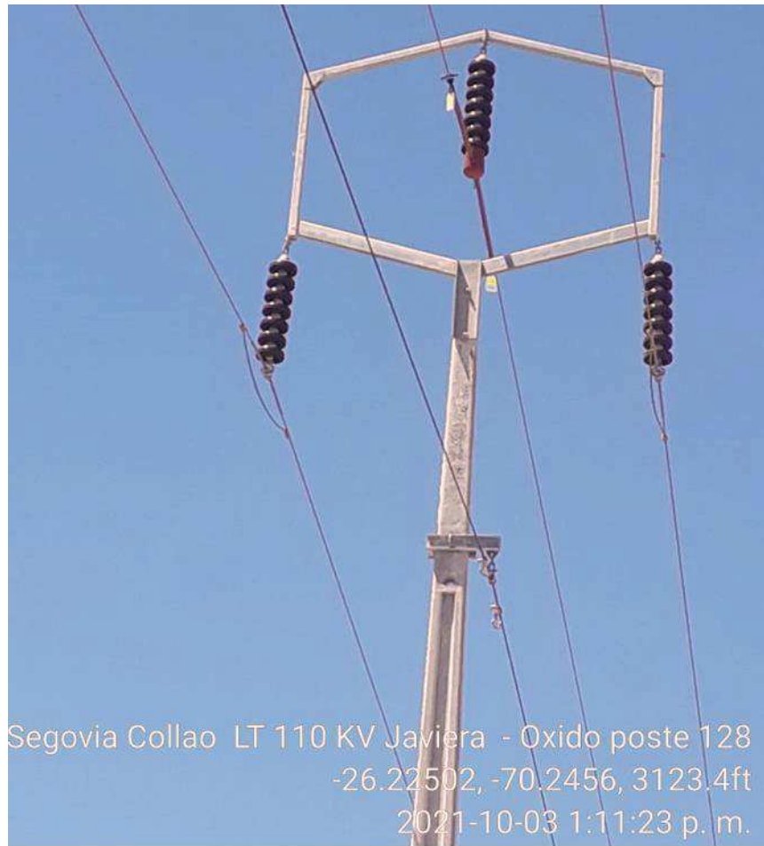
Figura N° 3 Detalle trabajos realizados en estructura N° 128
