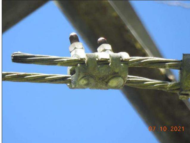
Fotografía 2 se aprecia una imagen ampliada donde ocurrió el arco eléctrico en la estructura N°145.
