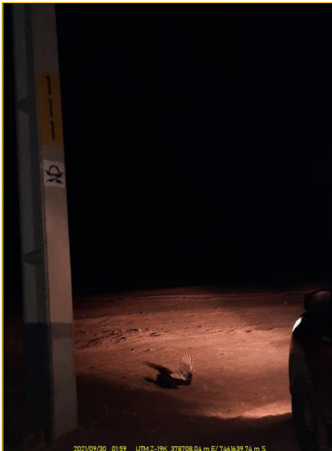
Fotografía N°1 muestra evidencia del ave que ocasionó la operación de la línea 66 kV Bombeo 2 - Bombeo 3.
