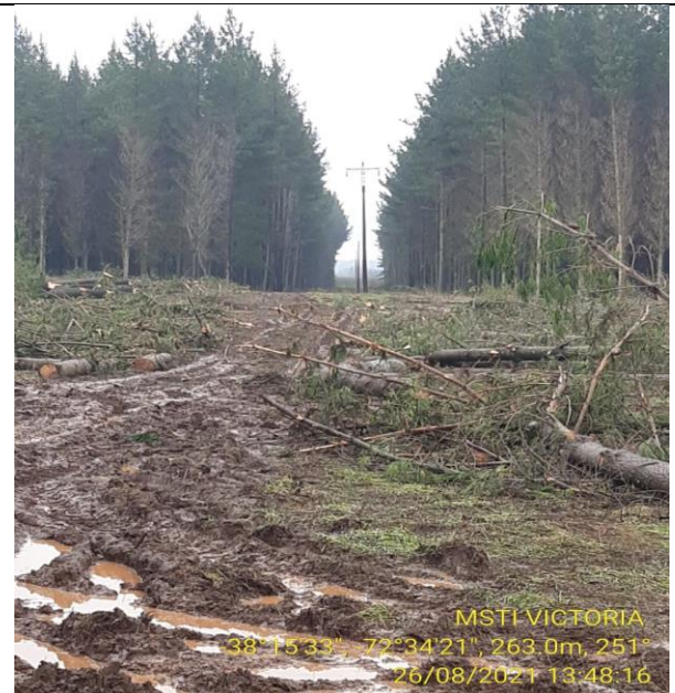
DESPUÉS ( VANO DESPEJADO )
