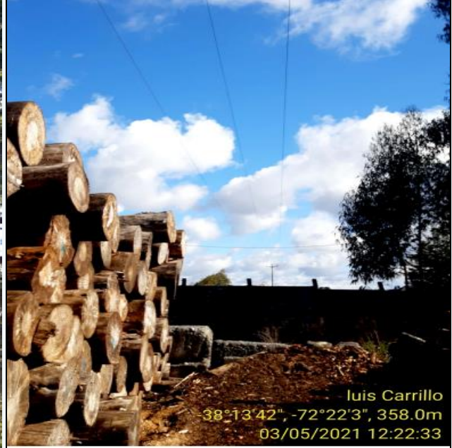
ANTES (VANO VISTA E29 HACIA E30)
