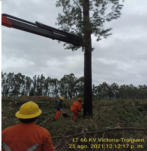
DURANTE / APOYO CAMION PLUMA
