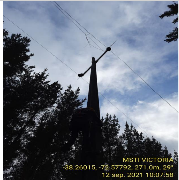
FASE CENTRAL CORTADA Y LATERAL RETENIDA
