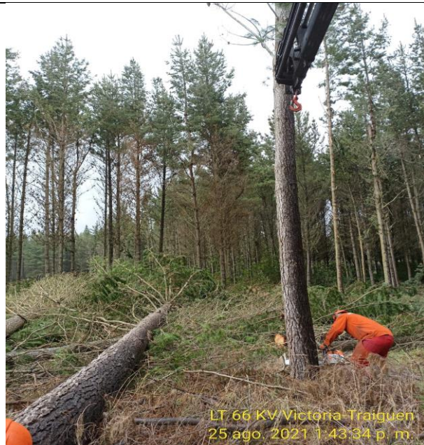
DURANTE / APOYO CAMION PLUMA
