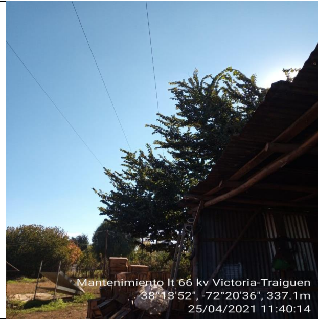
ANTES (VANO E18 A E19)
