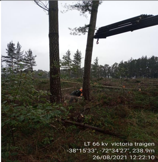
DURANTE / APOYO CAMION PLUMA
