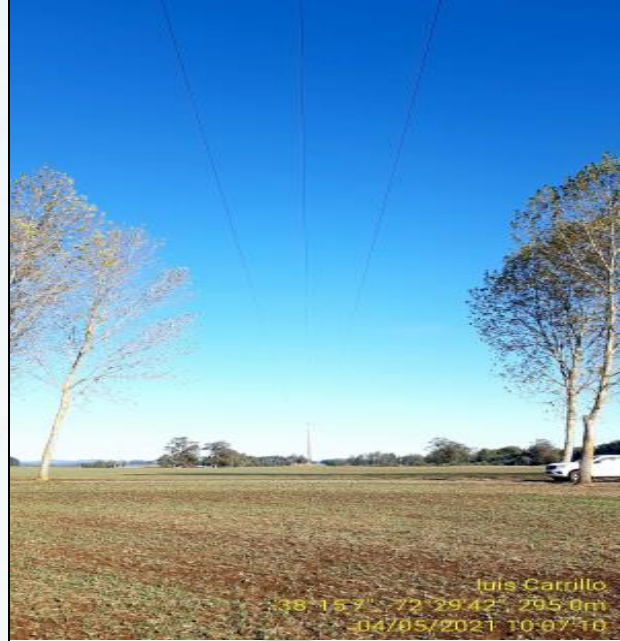
ANTES (VANO VISTA E76 HACIA E77)
