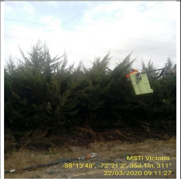
DURANTE-EST 24 LADO CARRETERA 5 SUR
