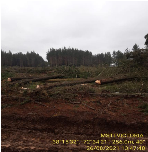
DESPUÉS ( VANO DESPEJADO )
