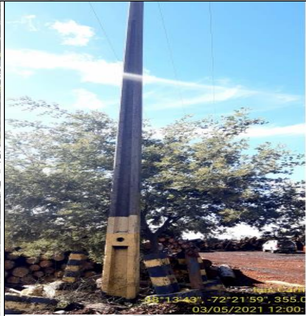
ANTES (VANO VISTA E29 HACIA E28)
