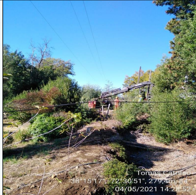
ANTES (VANO VISTA E84 HACIA E85)
