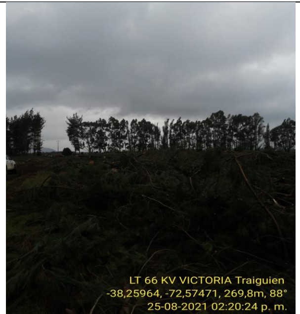
DESPUÉS ( VANO DESPEJADOS)
