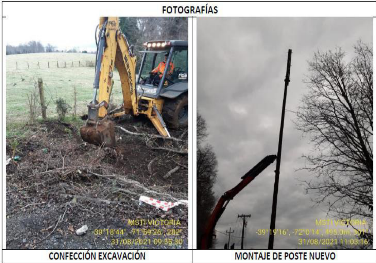
Fotografía N°7. LT66kV Villarrica – Pucón. Faena de reparación en vano E394 y E395
