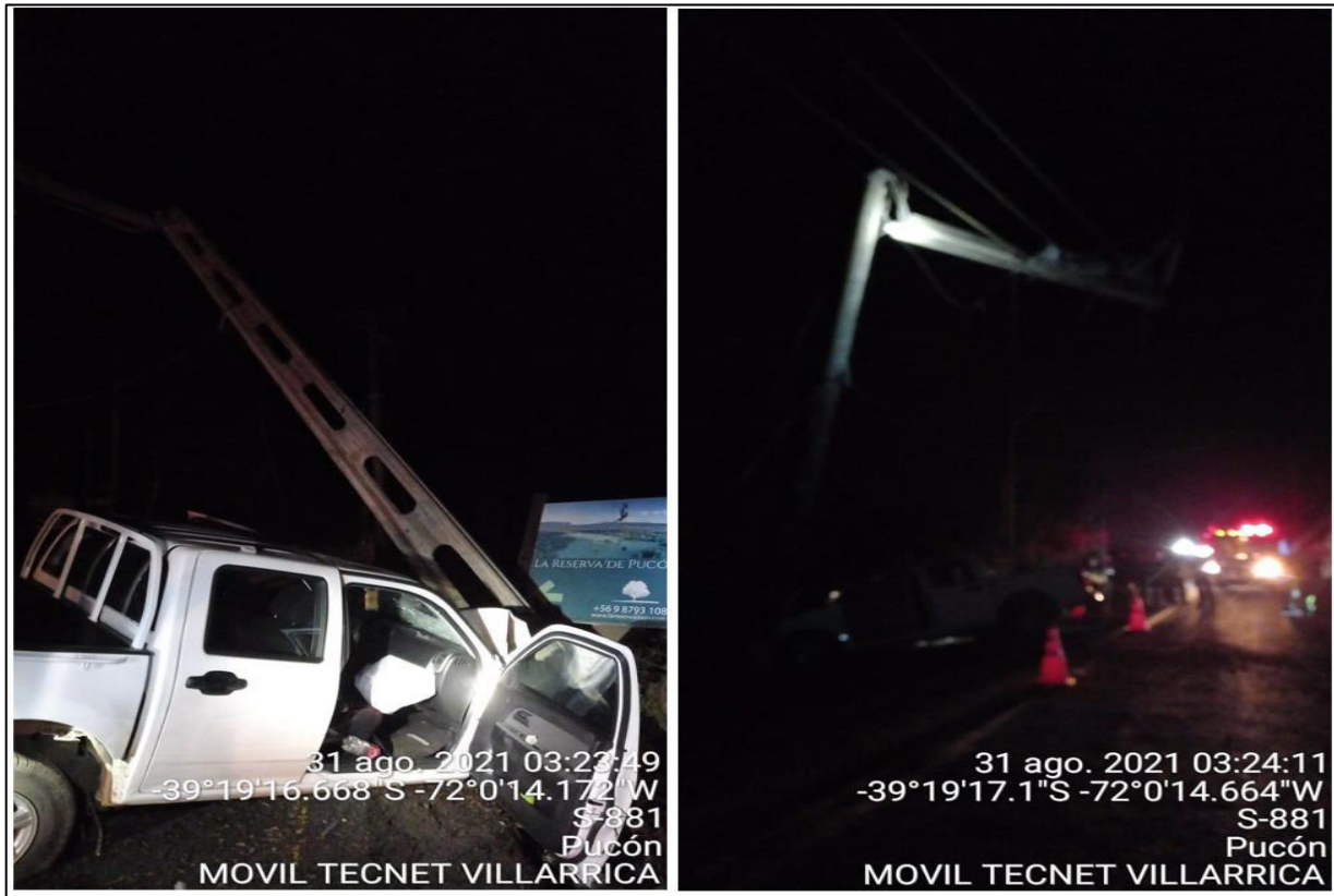
Fotografía N°1. LT66kV Villarrica – Pucón. Punto falla en estructura N°394. Choque a poste ocasionado por vehículo de terceros
