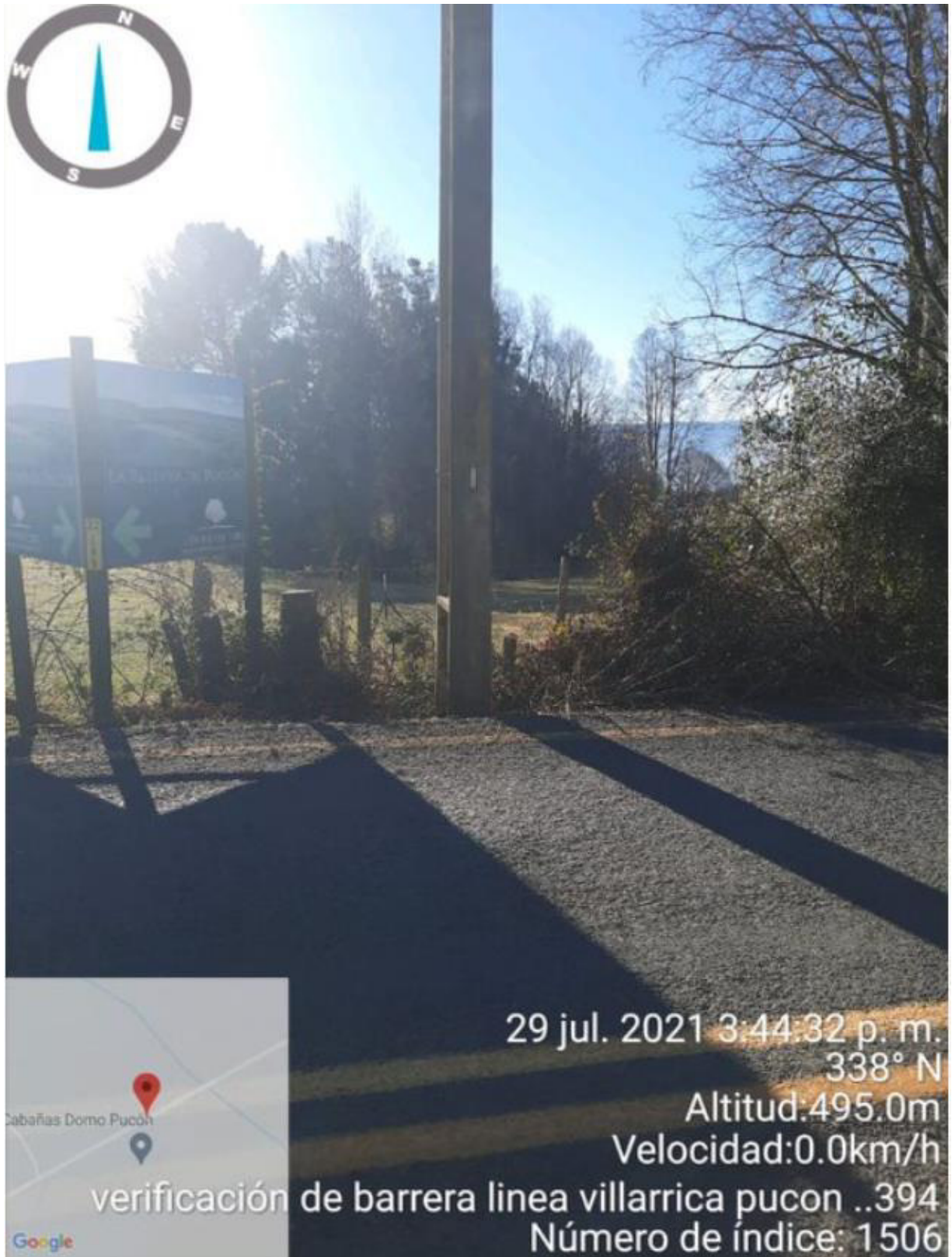
Fotografía N°12. LT 66KV VVillarrica – Pucón. Soporte o barra de contención en Estructura N°394 posterior a pavimentación de ruta S-881.
