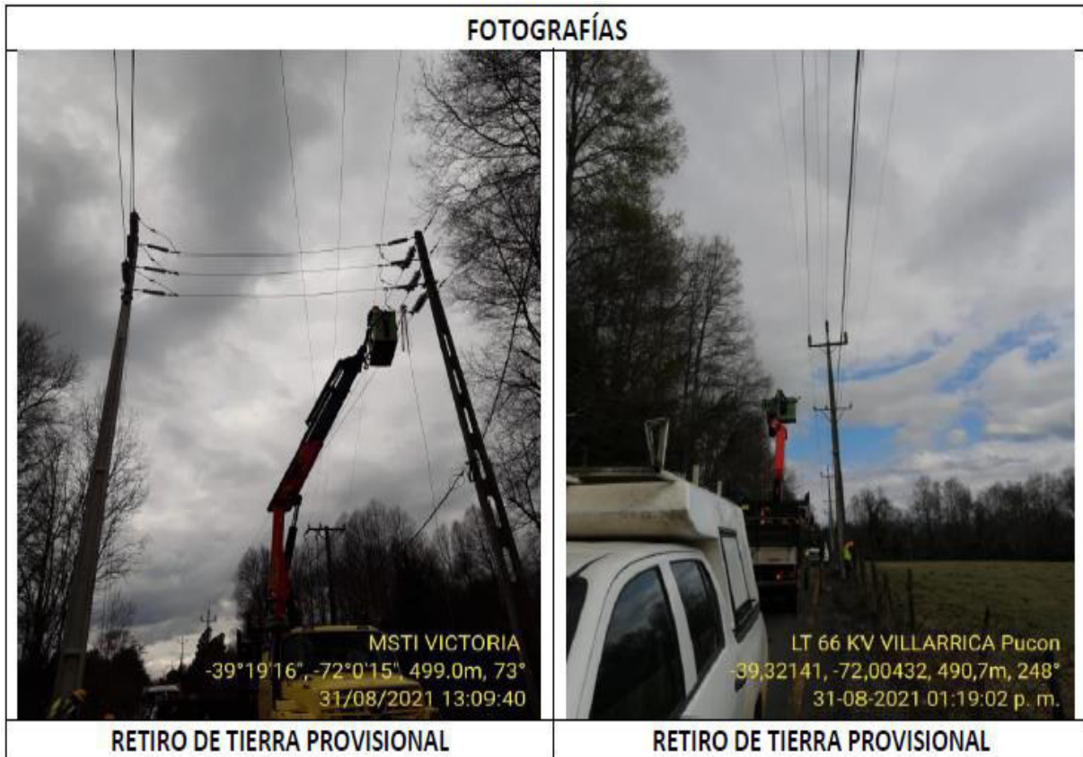
Fotografía N°8. LT66kV Villarrica – Pucón. Faena de reparación en vano E394 y E395
