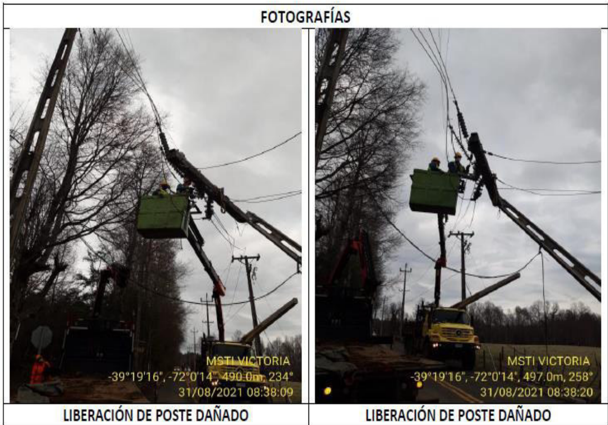
Fotografía N°5. LT66kV Villarrica – Pucón. Faena de reparación en vano E394 y E395
