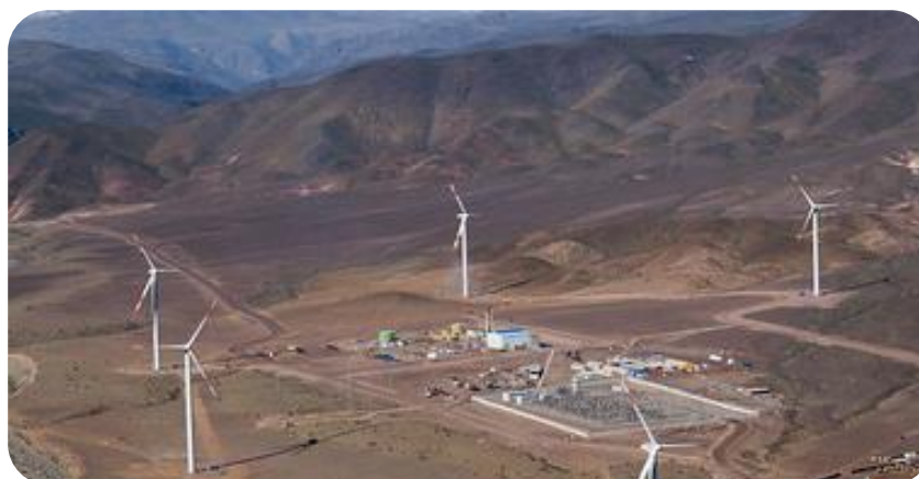
Ilustración 4.1 – Vista General Central Térmica Punta Colorada
