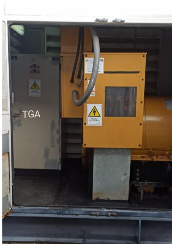
Figura 9.7 – Puntos de instalación TTCC externo
