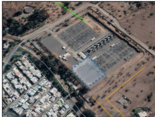
Figura 4-53. Zona emplazamiento Nueva S/E Norte.
