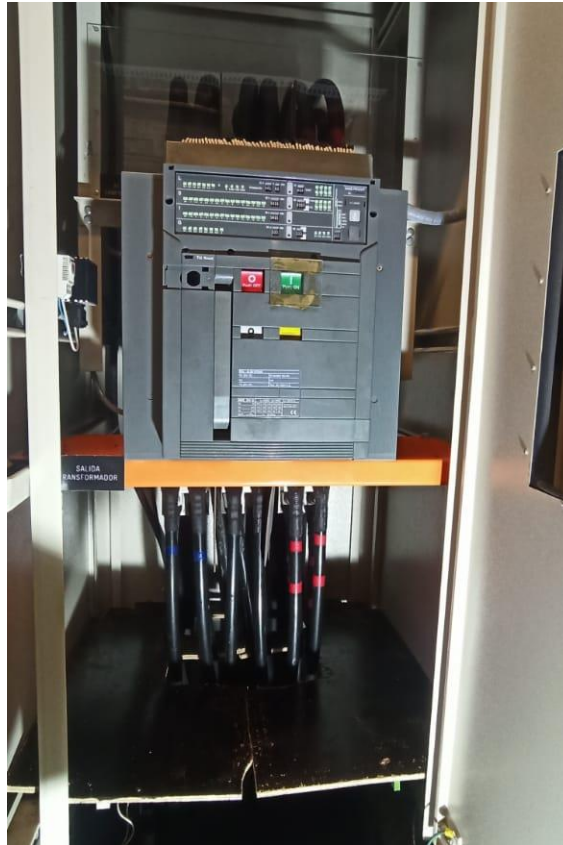
Figura 9.6 – Puntos de instalación TTCC externo
