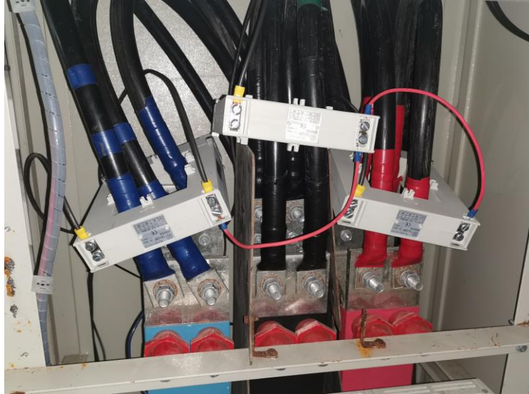
Figura 9.34 – Conexión TTCC externos
