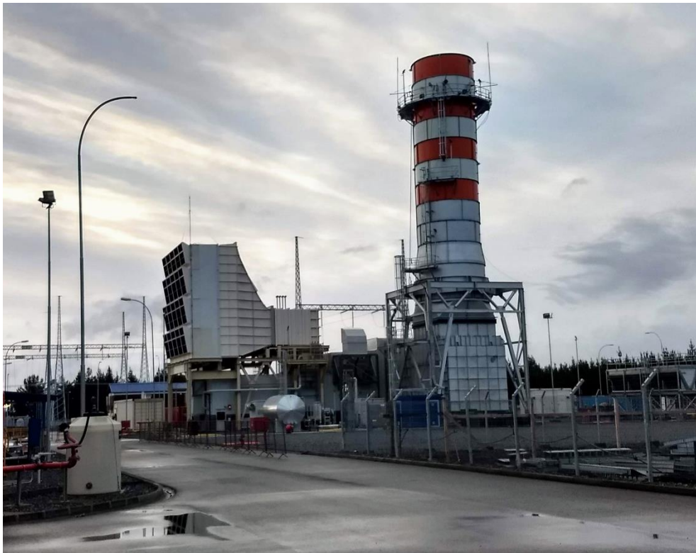
Figura 1. Central Los Guindos, Unidad 02.
