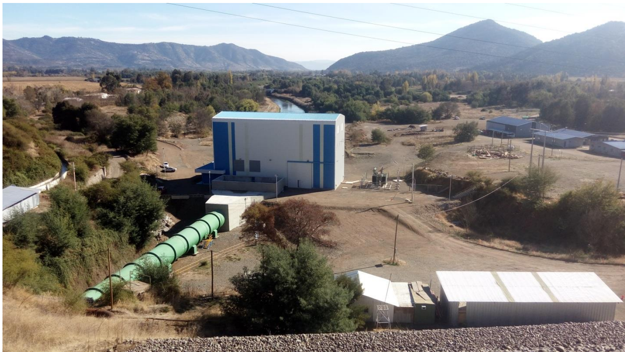
Figura 3.1: Central Hidroeléctrica Convento Viejo.
