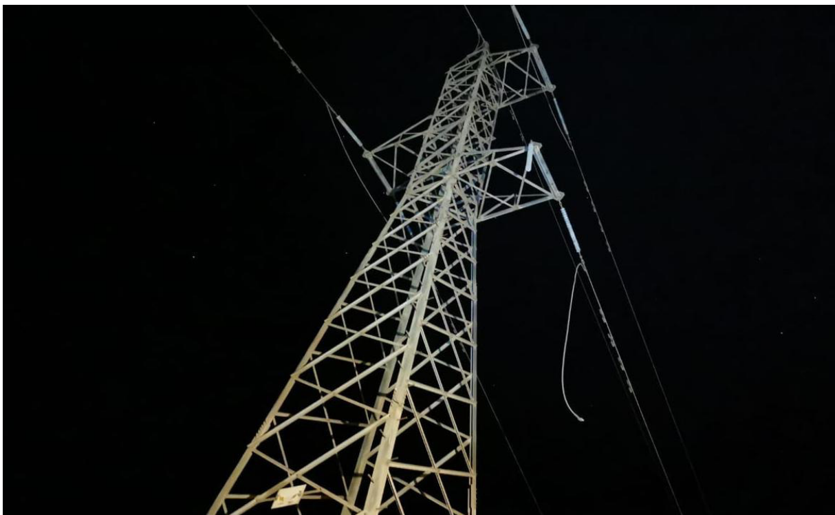
ESTRUCTURA N°16 LINEA ESMERALDA SUR 110 KV DONDE SE PRODUCE CORTE AISLADOR POLIMERICO FASE A
