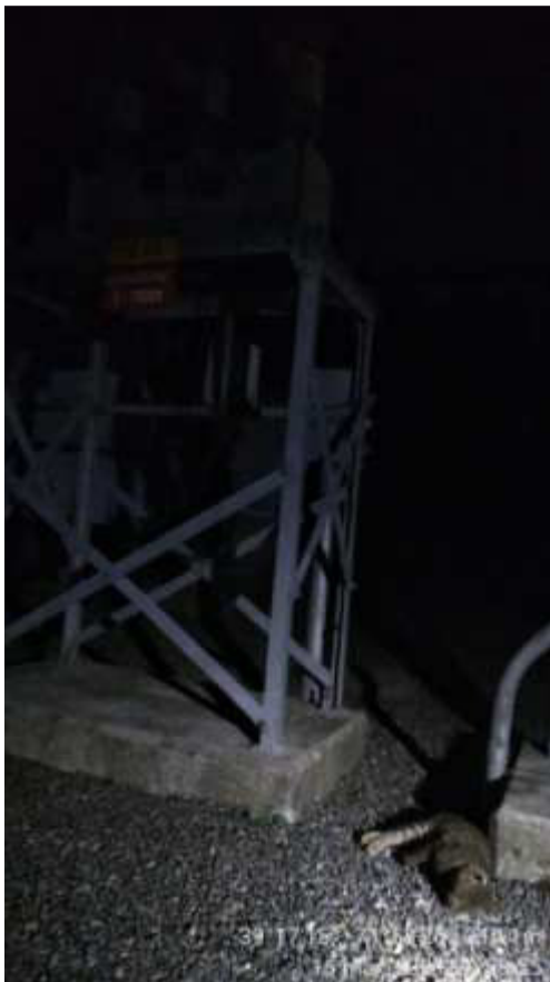
Fotografía N.º 3. S/E Pucón, Situación encontrada post falla 16/03/2021
