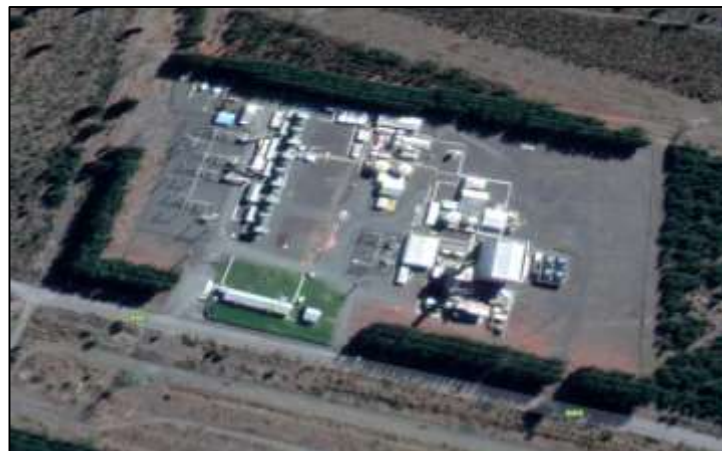
Figura 4.1 Ubicación Central Termoeléctrica Yungay.
