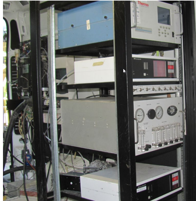
Figura 3-11 Instalación Analizadores de Gases
