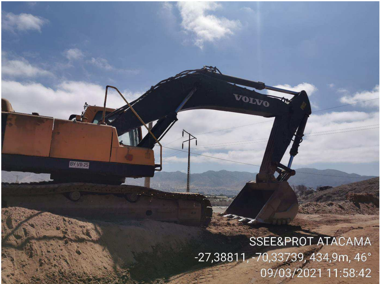
Fotografía N°1 Evidencia de maquina excavadora trabajando cercano a LT 110 kV Cardones - Copiapó
