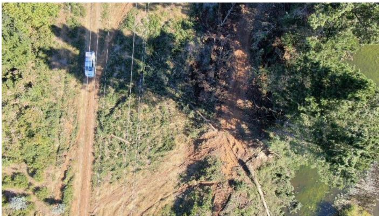
Figura 10: Vista aérea del lugar de la falla (dron). Fuente: Transelec.
