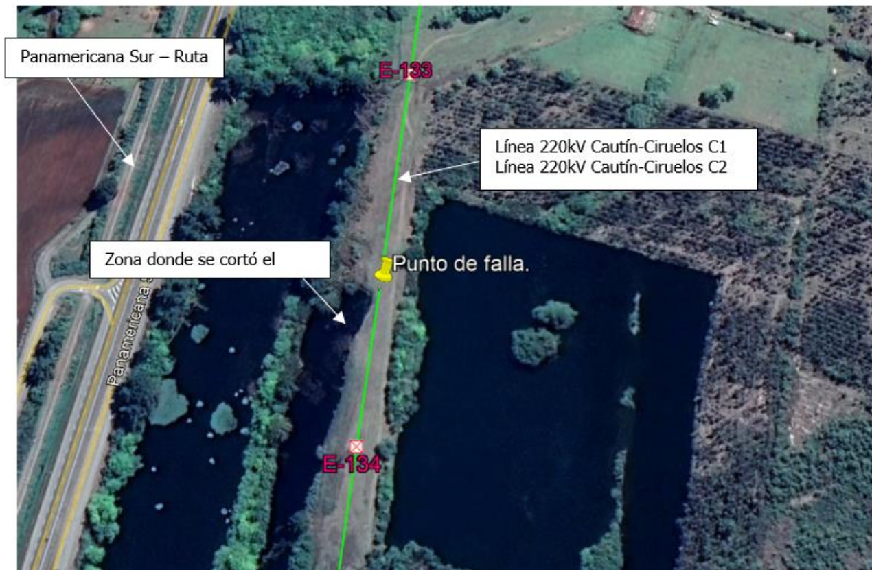
Figura 8: Vista panorámica del punto de falla.
