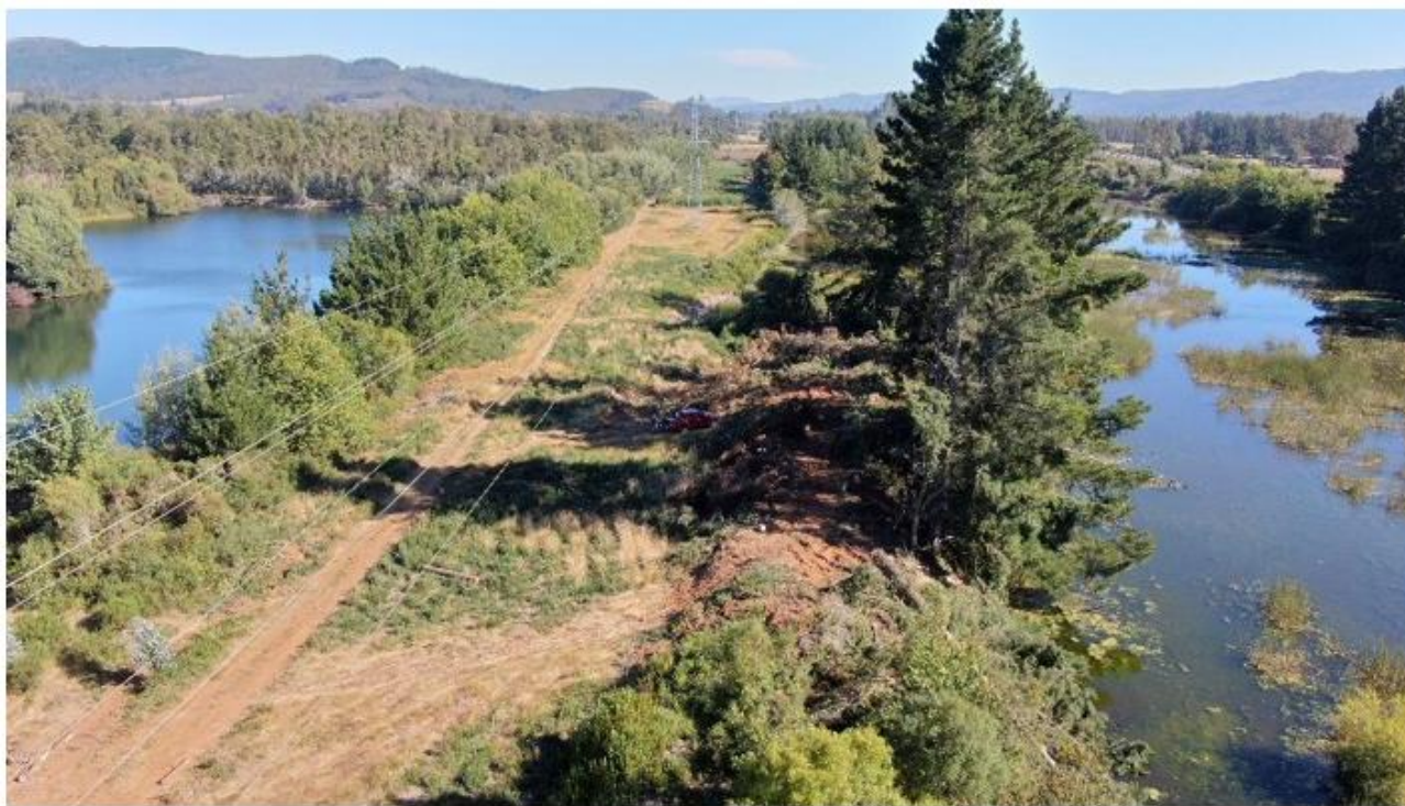
Figura 11: Vista aérea del lugar de la falla (dron). Fuente: Transelec.
