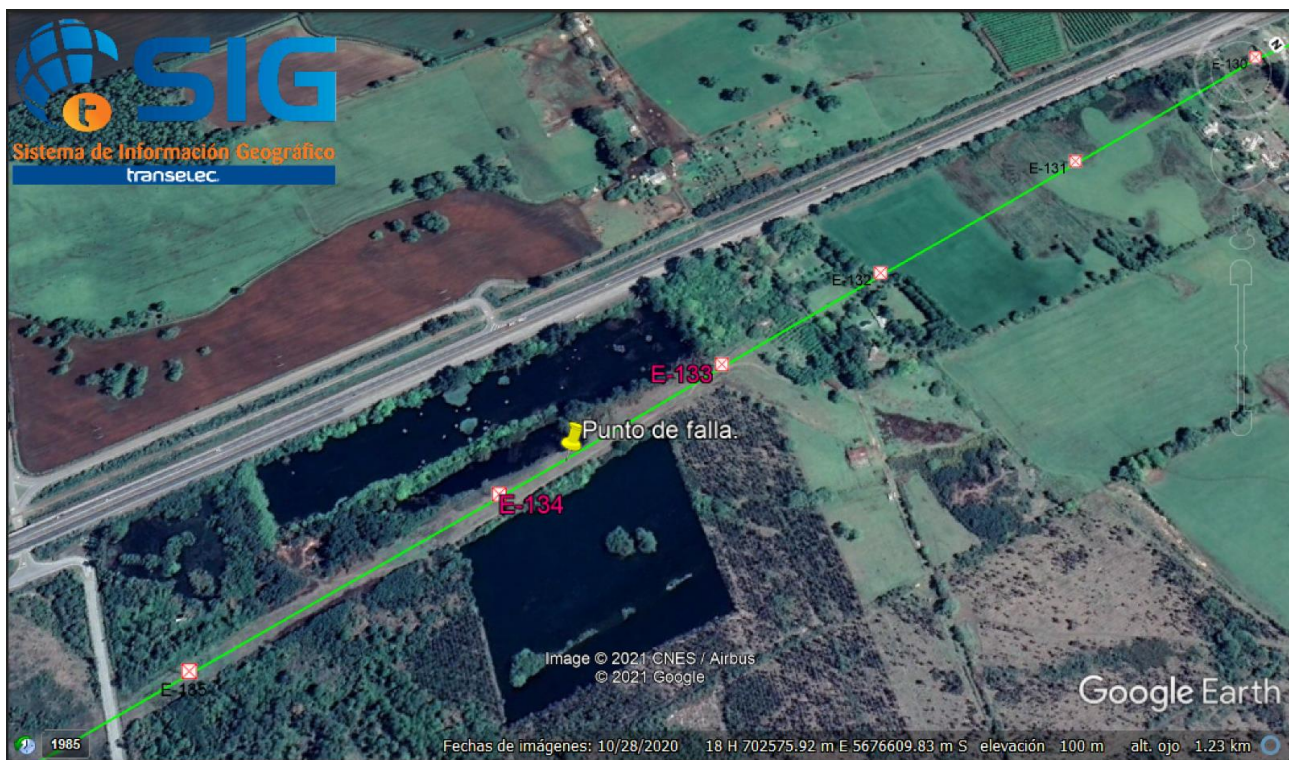
Figura 18: Vista aérea Google Earth, estructura N°133 y N° 134 línea 220 kV Cautín-Ciruelos C1, tramo Seccionadora Rio Toltén – Ciruelos Circuito 1
