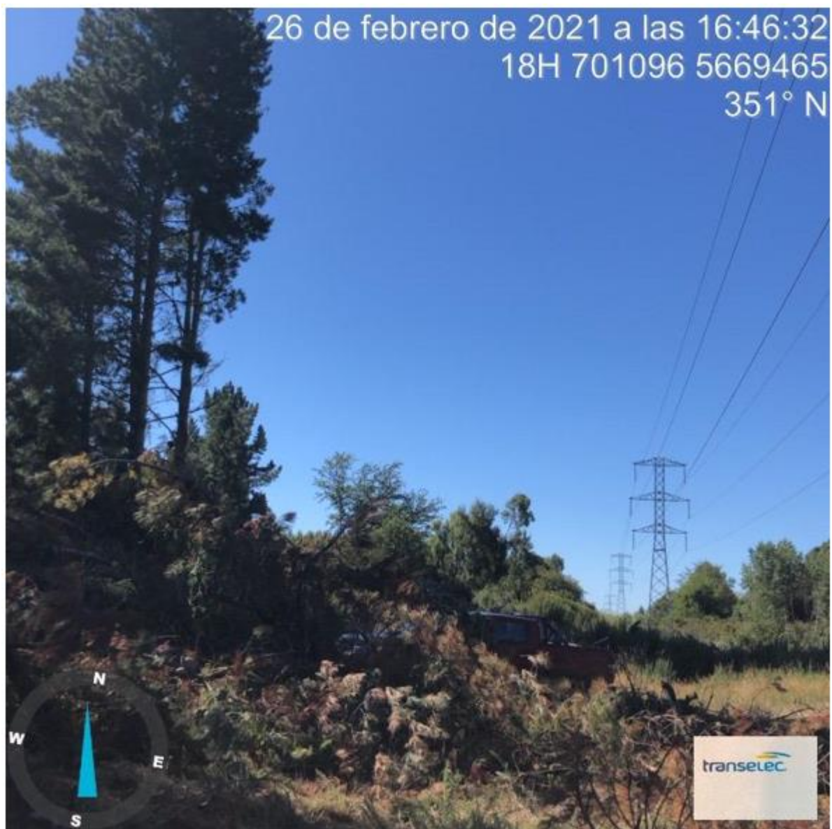
Figura 15: Árbol que ocasionó la falla. Fuente: Transelec.
