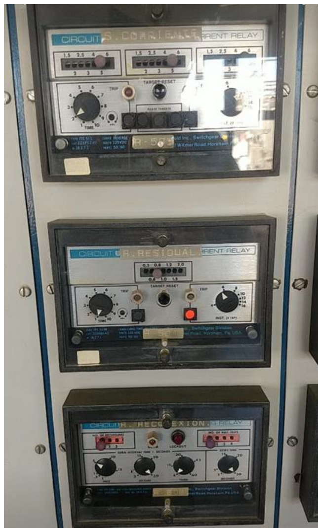
Registro fotográfico relés electromecánicos paño C3 S/E Ejército
