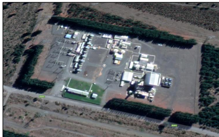
Figura 5.1 Ubicación Central Termoeléctrica Yungay.
