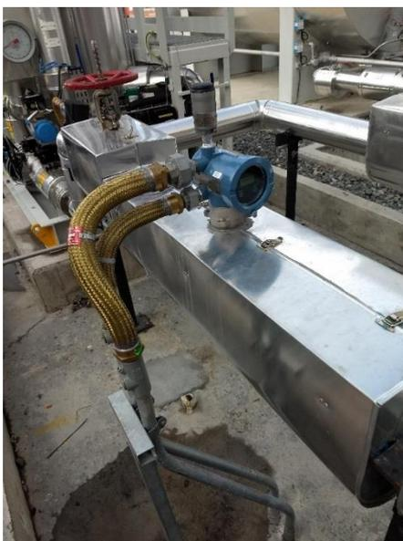
Figura 8. Flujómetro tipo Coriolis.
