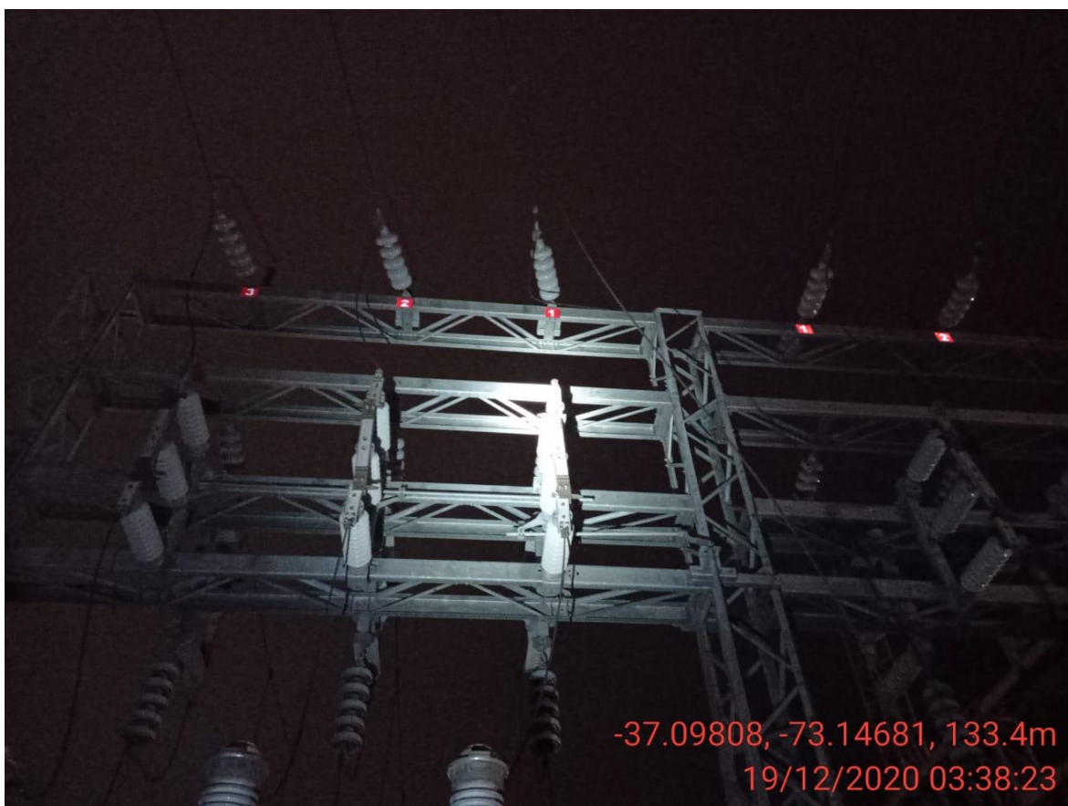
Imagen N°1: Se muestra al conductor cortado de la fase “A” en la salida del DDCC 89B2-2 de S/E Andalicán.
