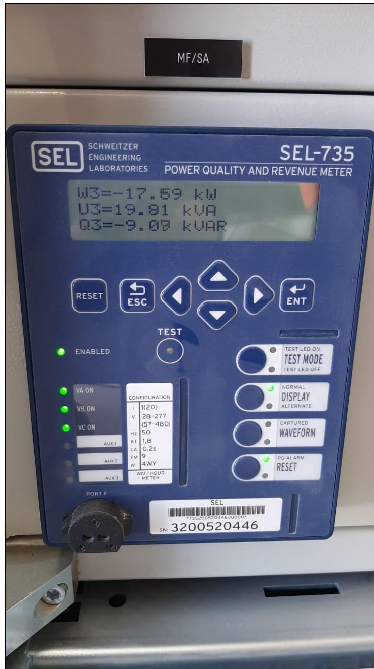
Figura 9-4 Registro 3 potencia activa SSAA.
