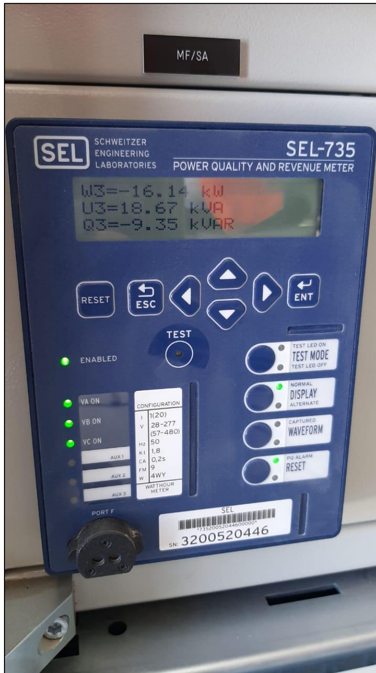
Figura 9-6 Registro 5 potencia activa SSAA.
