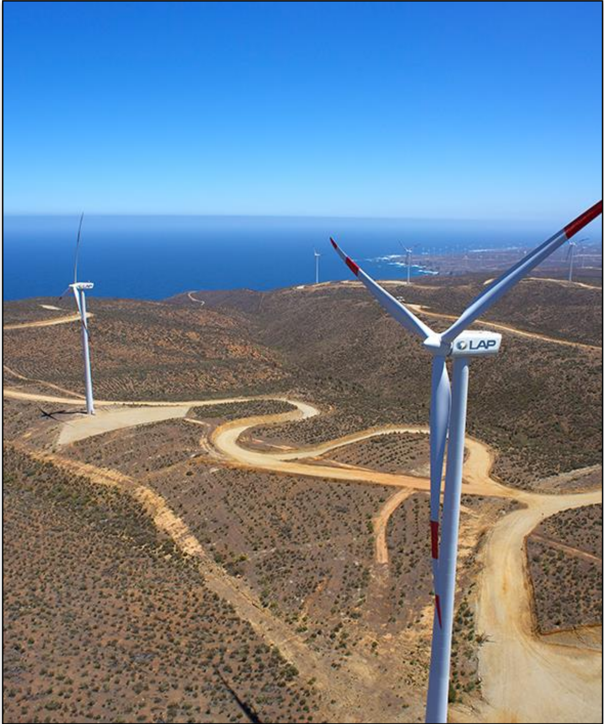
Figura 2.5.1. Vista general de la distribución del Parque Eólico Totoral.
