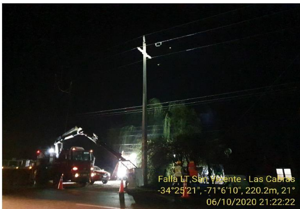
Imagen N° 4: Imagen muestra instalación en vano 10 – 11 LT66kV San Vicente TT – Las Cabras normalizado
