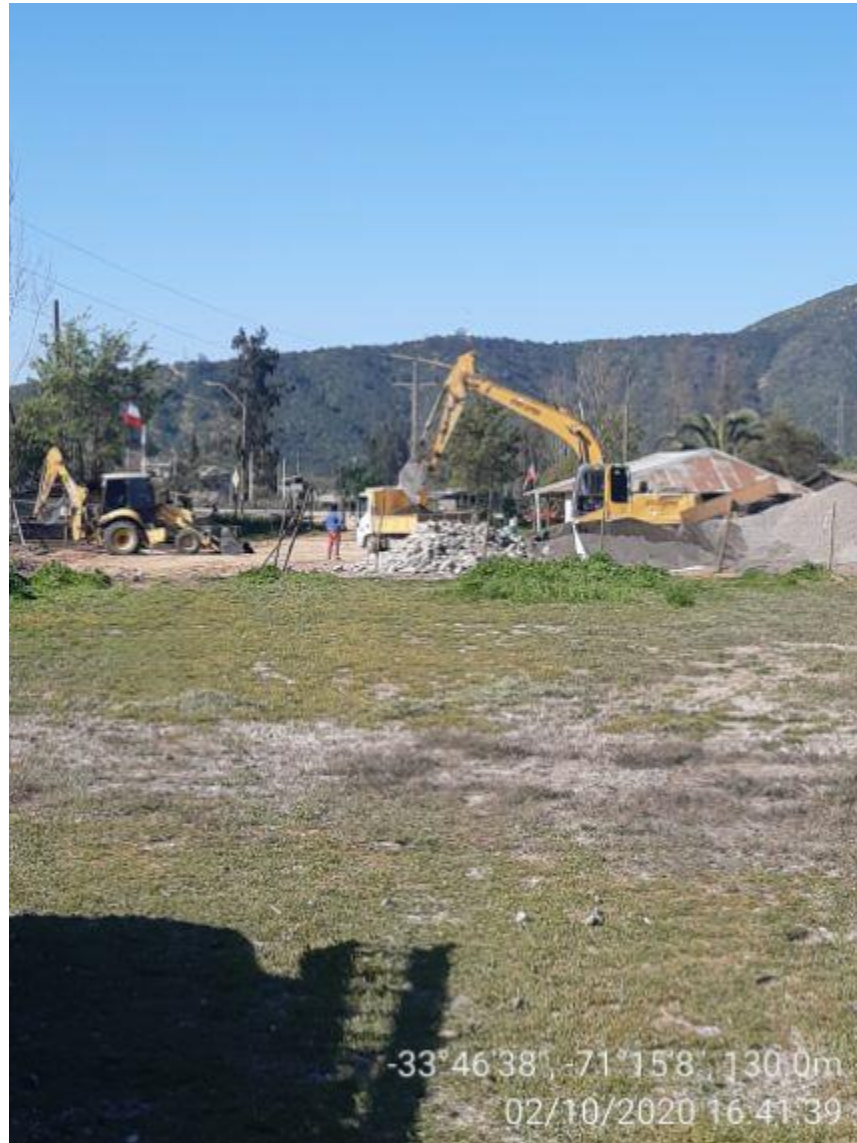
Fotografía 2: Vista hacia el norte de Vano de Línea entre Est. 50-51 de LT 66kV Chocalán – Mandinga, donde se aprecian dos maquinarias pesadas, 1 máquina retroexcavadora y 1 máquina excavadora con oruga.
