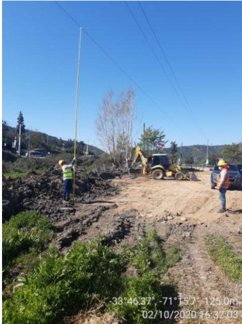
Fotografía 4: Labores de medida de altura con pértiga aislada de Vano de Línea entre Est. 50-51 de LT 66kV Chocalán – Mandinga en el último punto de falla.
