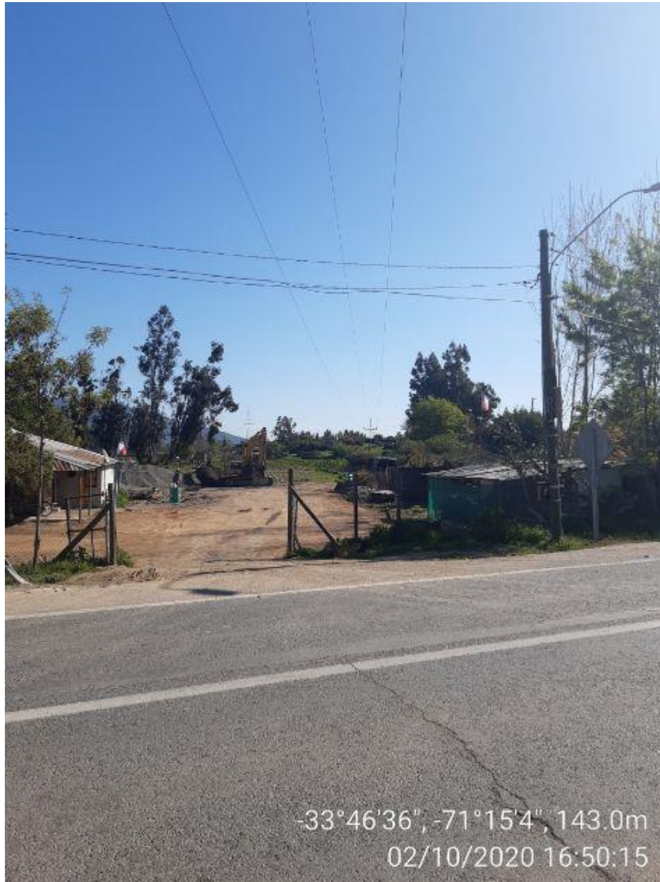
Fotografía 3: Vista hacia el sur de Vano de Línea entre Est. 50-51 de LT 66kV Chocalán – Mandinga, donde se aprecian dos maquinarias pesadas, 1 máquina retroexcavadora y 1 máquina excavadora con oruga.
