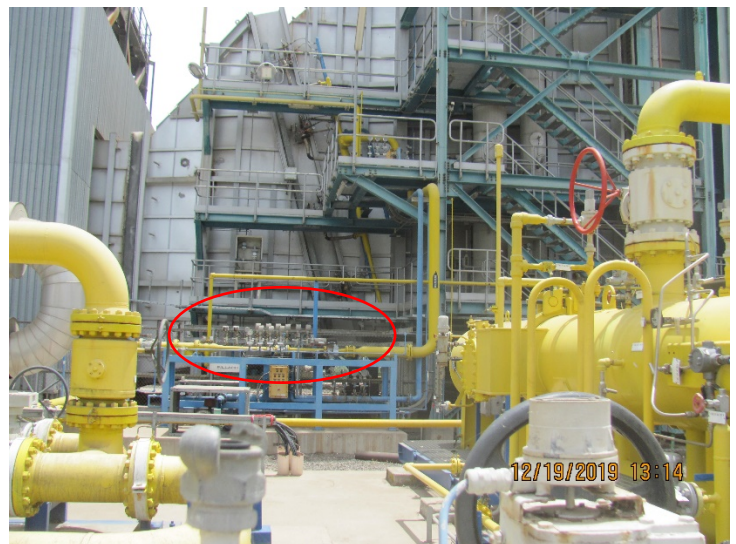
Figura 3.5 UBICACIÓN MEDIDOR DE COMBUSTIBLE A FA HRSG
