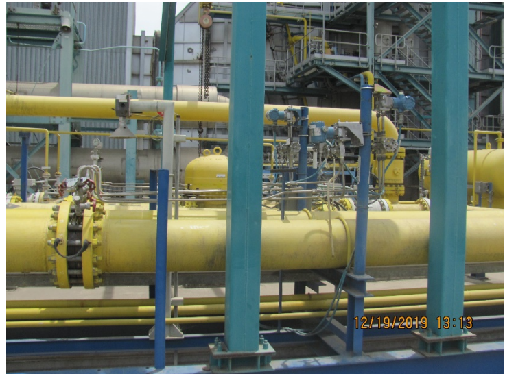
Figura 3.4 UBICACIÓN MEDIDOR DE COMBUSTIBLE TG
