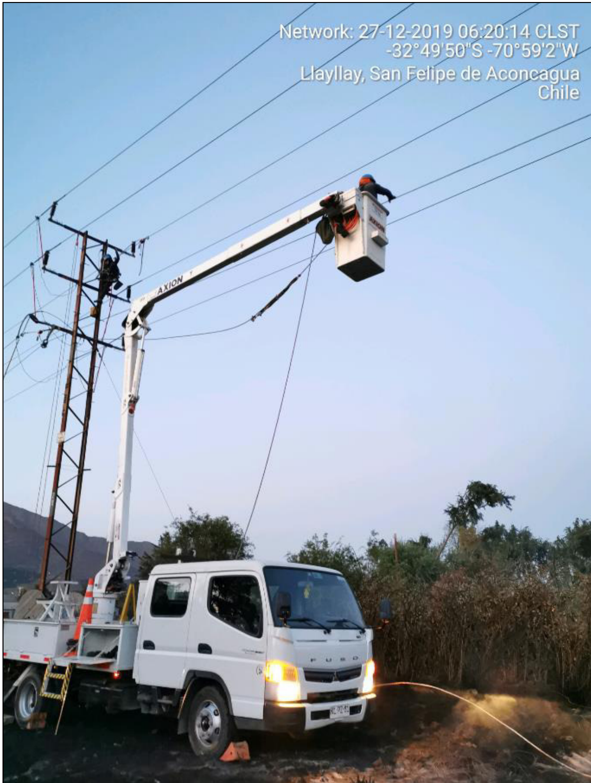
Figura 4: Trabajos de reparación y reemplazo de los aisladores y conductores en la estructura N°29.
