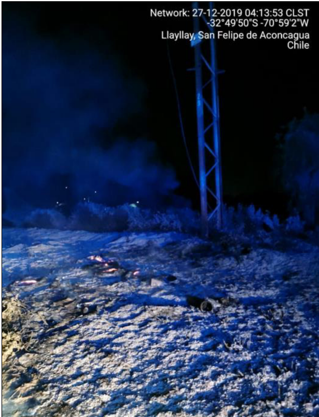
Figura 1: Estructura N°29 de la Línea 44 kV Las Vegas-Los Andes. Incendio forestal, fenómeno físico de la falla que afectó a los Circuitos N°1 y N°2.
